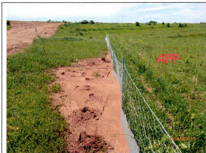
Foto 2: Vista em detalhe do sedimento retido. Observa-se que não houve carreamento de sedimento para a APP.
