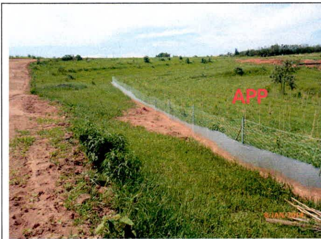
Foto 1: Vista em detalhe da barreira de sedimentos implantada no limite da APP. Observa-se o sedimento retido indicando o bom funcionamento do dispositivo.
