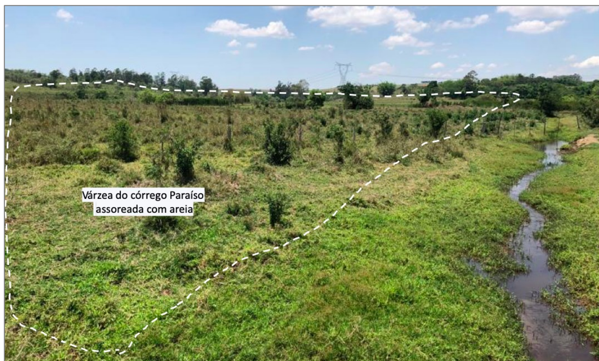
Figura 5 – Várzea assoreada do córrego Paraíso.
