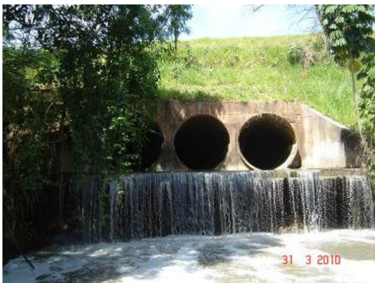
FOTO 2. Vista de jusante da tubulação existente sobre a Rod. D. Pedro I. Esta tubulação será acoplada à uma caixa de concreto armada a fim de proporcionar o amortecimento da onda de cheia da BD-3.
