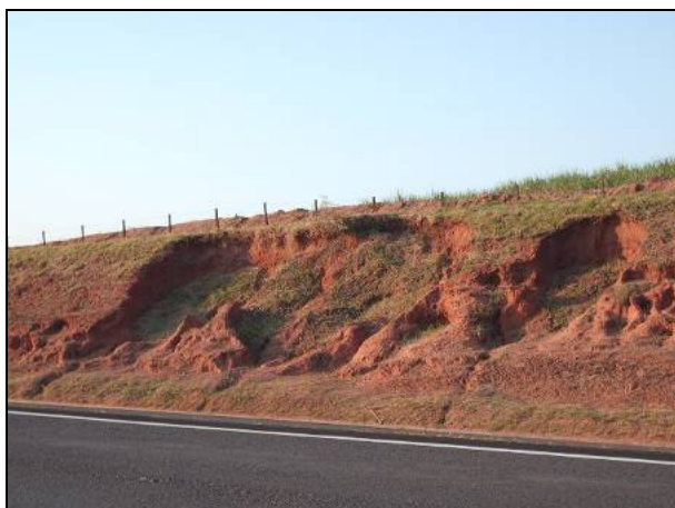
Figura 8.1.3.2-447. Detalhe de sulcos erosivos em talude da Rodovia Marechal Rondon (SP-300), no município de Guarantã.
