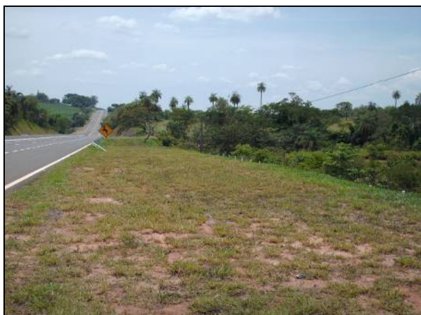
Figura 8.1.3.2-364. Travessia do Córrego Quente onde há aterro arenoso, com processo inicial de erosão laminar.
