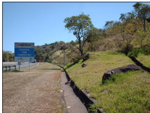
Figura 8.1.3.2-177. Local suscetível a ocorrência de rolamento de blocos de basalto e arenito silicificado nas margens da SP-310 (Rodovia Washington Luis) na Serra dos Padres. Trecho com incidência constante de processo de rastejo.
