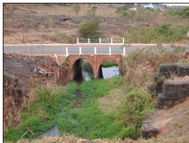
Figura 8.1.3.2-284. Detalhe da travessia do Ribeirão Jataí (travessia 12) no município de Tanabi que apresenta obras de contenção da erosão com gabiões em suas margens e encostas. O leito da drenagem está intensamente assoreado.
