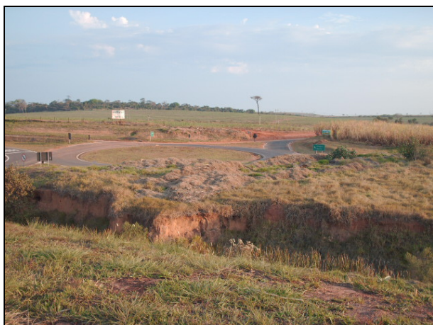
Figura 8.1.2.5-46. Travessia do Córrego Congonhas no município de Pirajuí, onde há uma boçoroca ocasionando assoreamento a jusante da drenagem.
