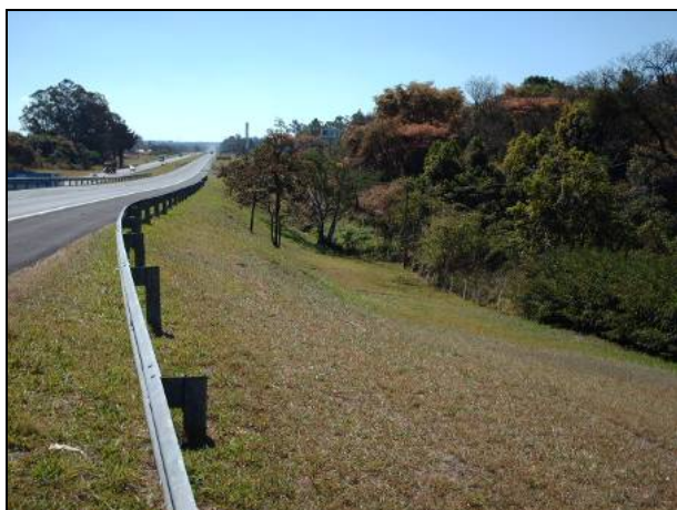
Figura 8.1.3.2-198. Detalhe da travessia do Córrego dos Macacos ou Conde que ocorre no aterro da rodovia, não atingindo a planície aluvionar e possivelmente o nível de água subterrâneo. Provável ocorrência de blocos rochosos no aterro, que podem causar problemas de escavabilidade.
