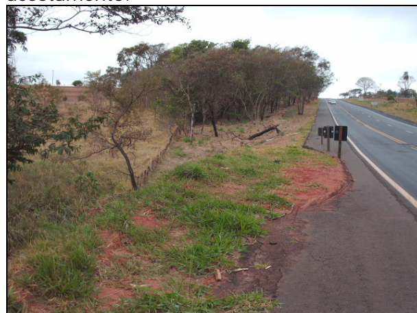
Figura 8.1.2.5-31. Travessia de afluente do Córrego do Retiro, no município de Cosmorama, onde se observa erosão linear afetando o acostamento (SP-320 - Rodovia Euclides da Cunha, pista norte).
