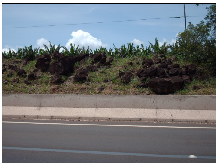
Figura 9.3-18. Presença de blocos rochosos de diabásio em talude na Rodovia SP-225 (Rodovia Engenheiro Paulo Nilo Romano). Local potencial para rolamento de blocos.
