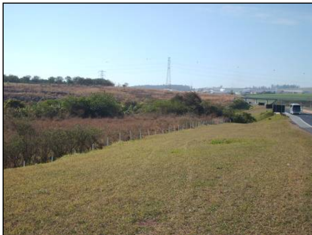
Figura 8.1.3.2-138. Detalhe da margem da Rodovia na travessia do Ribeirão Claro, onde pode-se observar que a planície aluvionar foi aterrada, mas dependendo da profundidade de escavação o nível de água pode ser atingido.
