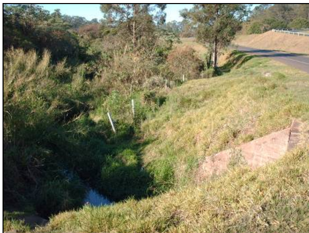
Figura 8.1.3.2-212. Detalhe da travessia de afluente do Rio do Monjolinho, com planície aterrada, mas com possível interceptação do nível de água e ocorrência de blocos rochosos.
