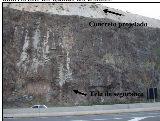
Figura 8.1.3.2-382. Vista geral do paredão citado nas figuras anteriores, onde se observa as telas de segurança e concreto projetado na parte superior.
