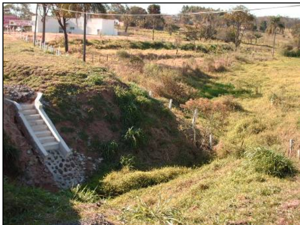
Figura 8.1.3.2-208. Detalhe da travessia do Córrego São João, onde nota-se a ocorrência de processo erosivo na margem e depósito de assoreamento em seu leito, inclusive a existência de escada de dissipação de energia das águas pluviais. Ocorrência de aterro sobre a pequena planície aluvionar.
