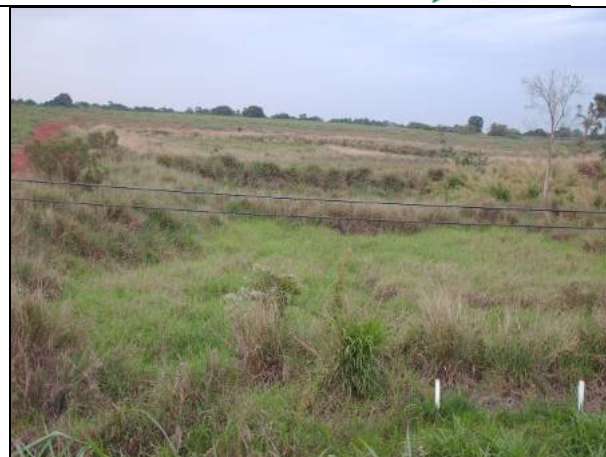
Figura 8.1.3.2-132. Travessia do Córrego do Cascalho com planície aterrada e possível afloramento de diabásio. Recomendação de travessia por furo direcional.
