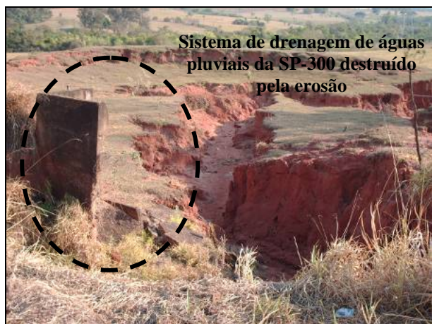
Figura 8.1.3.2-479. Processo erosivo (ravinamento) de grandes proporções ao lado da Rodovia SP-300, afetando inclusive o sistema de dissipação de energia da água pluvial e controle de erosão. Local situado na AID do empreendimento (492.732E/7.668.874N).
