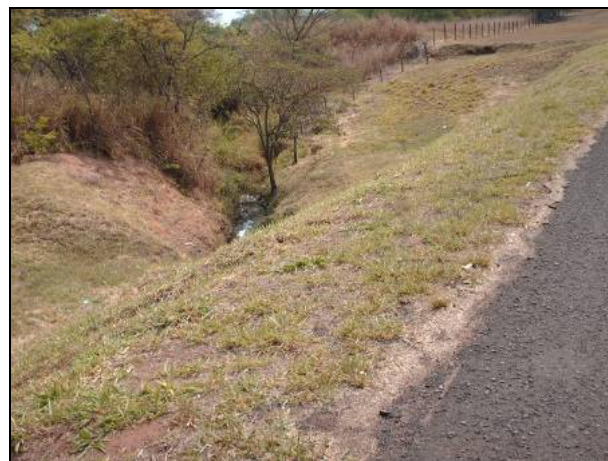
Figura 8.1.3.2-239. Detalhe de outra travessia de afluente do Córrego da Cascavel, que ocorrerá no aterro da rodovia SP-310, onde há a possibilidade de ocorrência de blocos rochosos que podem causar problemas de escavabilidade. Ocorrência de pequenos sulcos erosivos e erosão laminar (travessia 12).
