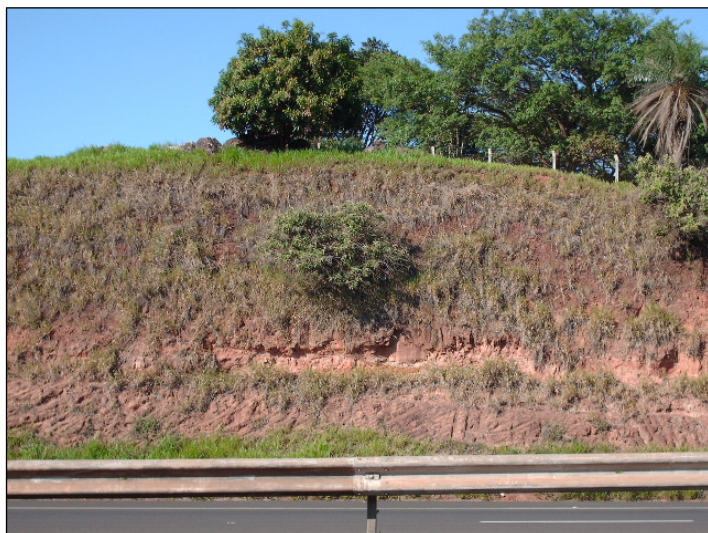
Figura 9.3-16. Feições de instabilidade em talude da SP-310, Pista Sul (ADA). Possível área de empréstimo.
