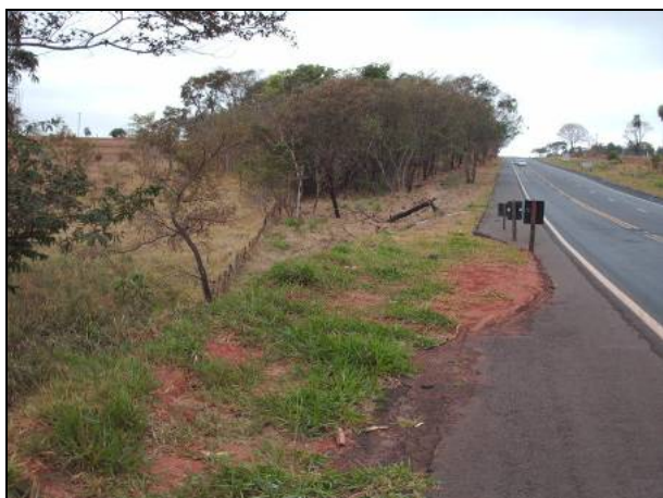
Figura 8.1.3.2-265. Travessia de afluentes do Córrego do Retiro (travessia 18), no município de Cosmorama, onde pode-se observar processo erosão linear, com instabilidade do talude da rodovia, inclusive afetando o acostamento (SP-320 -Rodovia Euclides da Cunha, pista norte).
