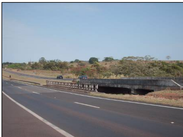
Figura 8.1.3.2-474. Detalhe da travessia do Córrego Barra Grande, onde a planície de um afluente acompanha a Rodovia SP-300 por cerca de 2.000m, estando aterrada. Possibilidade de solo mole e água e ocorrência de rochas (arenitos e siltitos).
