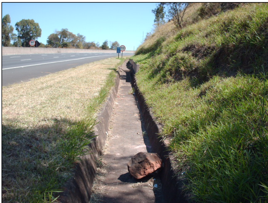
Figura 8.1.2.1-11. Detalhe de bloco de basalto que rolou do talude nas margens da Rodovia SP-310 (Washington Luis), na Serra dos Padres, atingindo o sistema de drenagem superficial.
