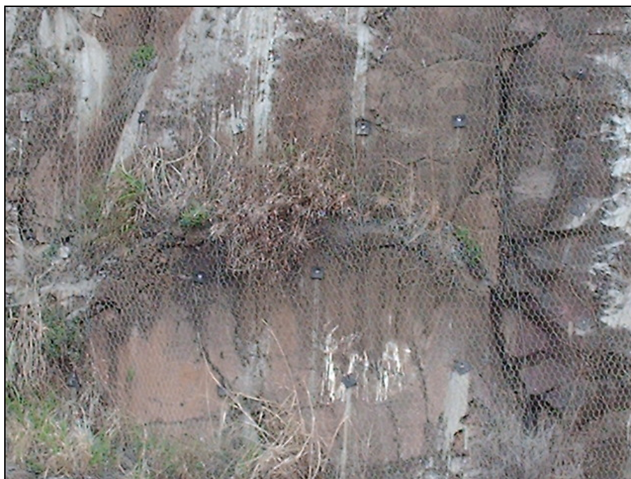
Figura 8.1.2.1-14. Detalhe da tela de segurança para controle de queda de blocos na pista Leste da Rodovia SP-225, no talude acima citado (Rodovia Engenheiro Paulo Nilo Romano).
