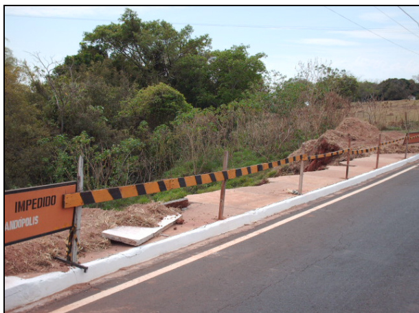
Figura 8.1.2.5-36. Afluente do Córrego da Aldeia com problemas de instabilidade gerado por processo de erosão e solapamento de margem, que afetou rua marginal a SP-320, na área urbana de Fernandópolis (local a cerca de 200 metros do traçado do poliduto, exclusivamente na AID).
