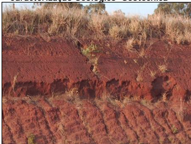
Figura 8.1.3.2-464. Detalhe do solo de alteração da Formação Santo Anastácio, onde existem sulcos erosivos implantados no talude.
