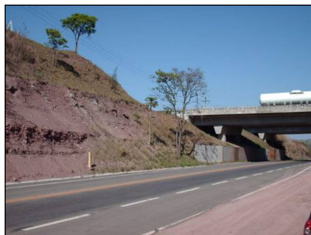
Figura 8.1.3.2-144. Detalhe da travessia da SP-310 (Washington Luis) com a rodovia SP-191, onde afloram siltitos e arenitos silicificados da Formação Corumbataí (rocha muito dura), problemas com escavabilidade e empastilhamento dos siltitos.
