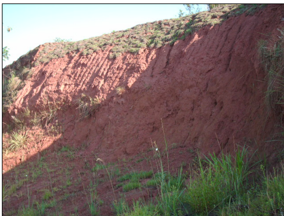
Figura 8.1.2.1-8. Presença de evidências de movimentação em talude da SP-310, Pista Norte (AID), como degraus de abatimento e cicatriz de escorregamento (774.983E/7.599.527N).
