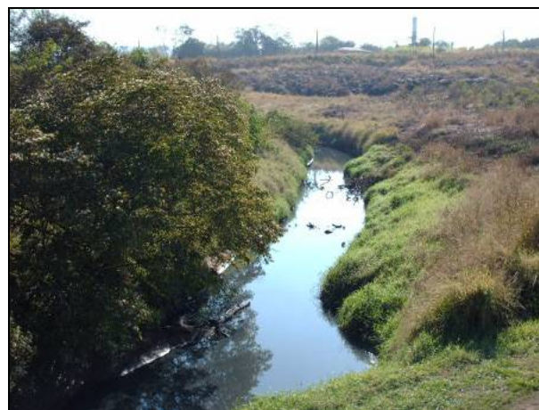
Figura 8.1.3.2-156. Detalhe da travessia do Ribeirão Claro na cidade homônima, onde o odor é forte, em especial, em épocas secas. Nas margens há presença de aterro de material arenoso, com capacidade de suporte média, mas possivelmente será atingido o nível de água subterrâneo. Recomenda-se a travessia por furo direcional.
