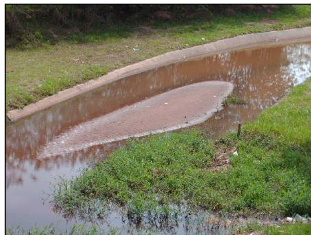
Figura 8.1.3.2-330. Travessia do Córrego da Lagoa Seca, onde pode-se observar a ocorrência de depósito de assoreamento em seu leito.
