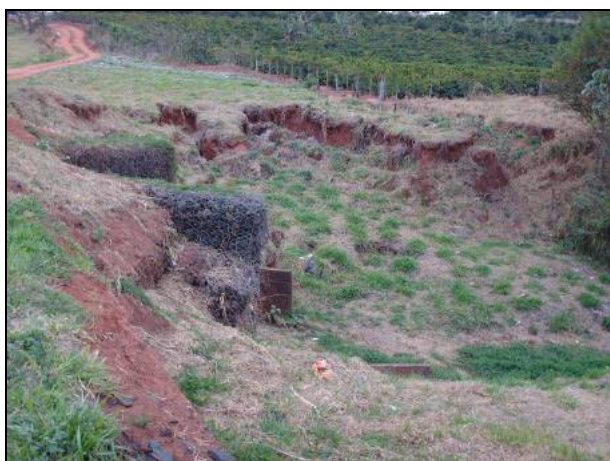
Figura 8.1.3.2-261. Detalhe da travessia do Córrego Perobinha (travessia 8) no município de Tanabi, onde pode-se observar processo de erosão nas margens e estrutura de gabião para contenção de ravinamento. Presença de depósito de assoreamento no leito.
