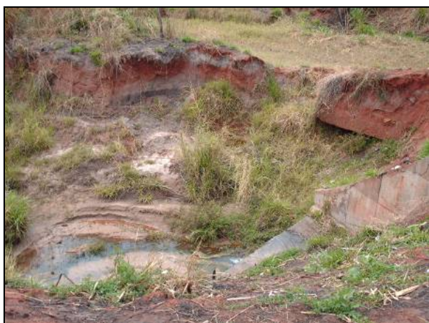
Figura 8.1.3.2-273. Travessia do Córrego do Galão e de seu afluente no município de Fernandópolis, onde ocorre intenso processo de erosão das margens e assoreamento do leito por sedimentos e fragmentos de concreto. A galeria de drenagem e o talude da rodovia estão sendo afetados (SP-320 - Rodovia Euclides da Cunha, pista norte).
