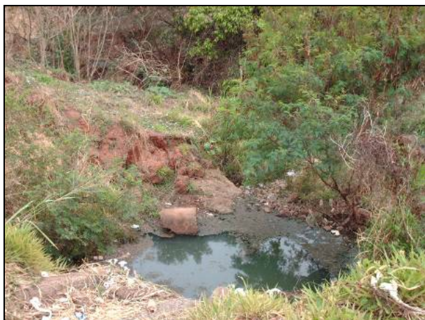
Figura 8.1.3.2-268. Travessia do afluente do Córrego Marinheiro (travessia 29) no município de Votuporanga, que apresenta processos intensos de erosão das margens e assoreamento (SP-320 - Rodovia Euclides da Cunha, pista norte).
