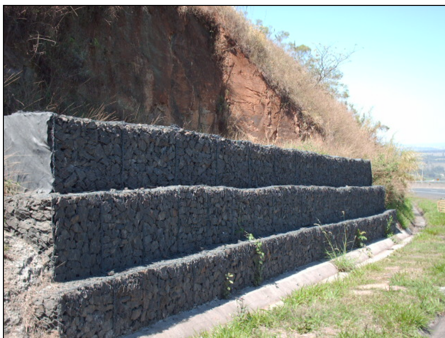
Figura 8.1.2.1-6. Detalhe de muro de arrimo feito de gabião para contenção de escorregamentos nas margens da Rodovia SP-310 (Washington Luis), na Serra dos Padres.
