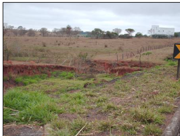
Figura 8.1.3.2-266. Travessia do Córrego Cevalim (travessia 20), com problemas com erosão das margens e assoreamento do leito, inclusive atingindo o acostamento da rodovia SP-320 (Rodovia Euclides da Cunha).
