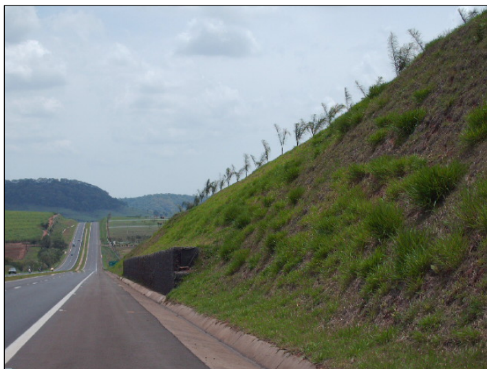
Figura 9.3-13. Muro de arrimo para contenção de escorregamento em talude da Rodovia SP-225 (Rodovia Engenheiro Paulo Nilo Romano).
