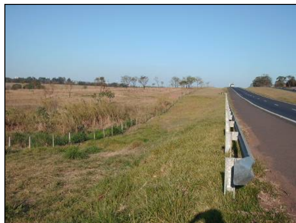
Figura 8.1.3.2-216. Travessia de afluente do Córrego. Sta Maria Madalena, que apresenta planície aterrada com possível ocorrência de blocos rochosos e interceptação do nível de água subterrâneo.
