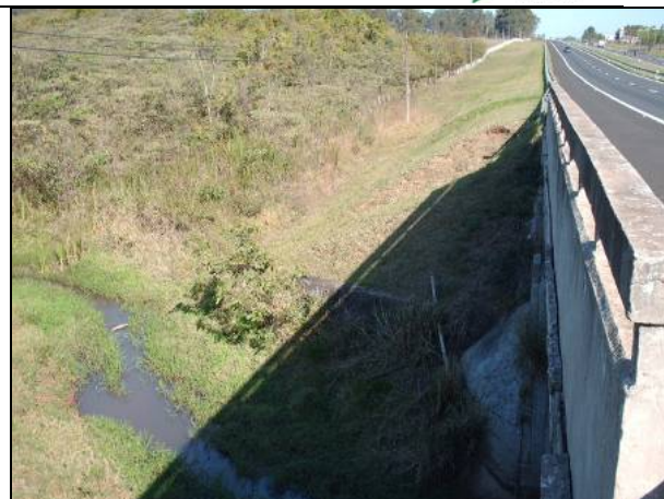
Figura 8.1.3.2-203. Detalhe da travessia de afluente do Córrego dos Macacos/Conde, onde ocorrem localmente sedimentos aluvionares de baixa capacidade de suporte.
