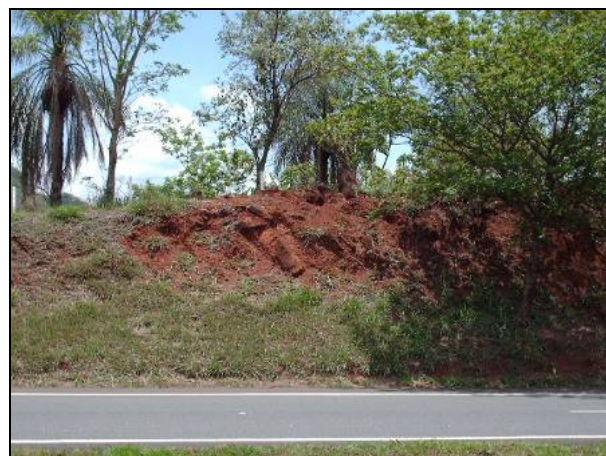
Figura 8.1.3.2-367. Matações de diabásio envoltos por solo de alteração em talude da Rodovia SP-225 (781.409E/7.537.371N). Obsaervar feições erosivas no talude.
