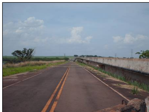
Figura 8.1.3.2-406. Detalhe da travessia do Rio Tietê, possível ocorrência de diabásio. Recomendação para realizar travessia aérea devido a largura do rio e possível presença de diabásio, sob sedimentos aluvionares grosseiros de baixa capacidade de suporte.
