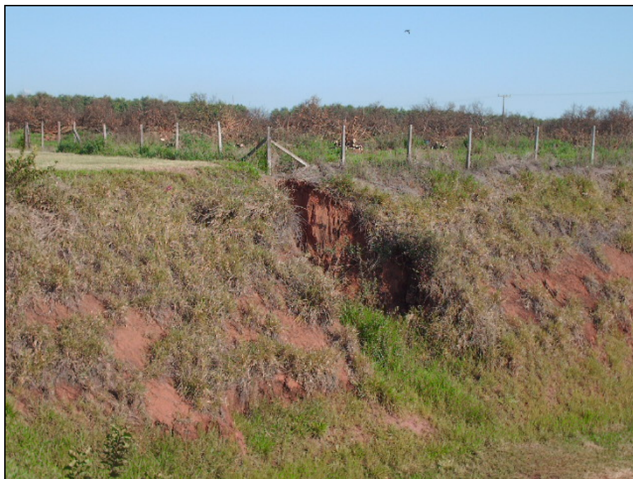
Figura 8.1.2.1-9. Feições de instabilidade em talude na SP-310, Pista Norte (AID) (773.102E/7.601.258N).
