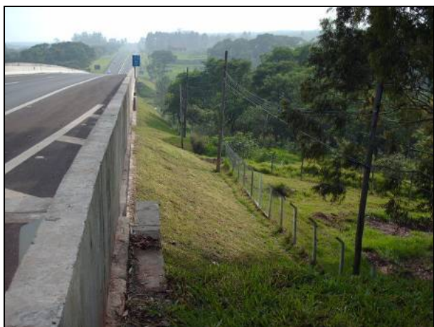
Figura 8.1.3.2-317. Detalhe da travessia de Afluente do Córrego da Água Branca, onde ocorre depósito de assoreamento.
