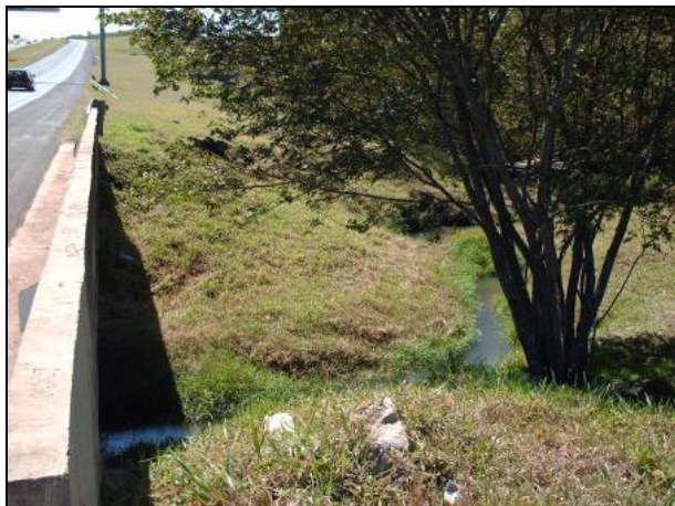
Figura 8.1.3.2-197. Detalhe da travessia do Ribeirão do Feijão, onde pode-se observar a presença de blocos rochosos no aterro da rodovia.
