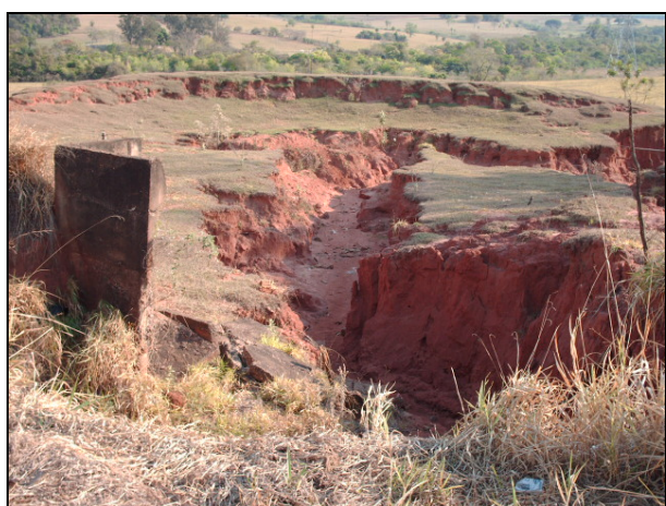
Figura 9.3-2. Processo erosivo (ravinamento) de grandes proporções ao lado da rodovia SP-300 (Rodovia Marechal Rondon), no município de Mirandópolis.
