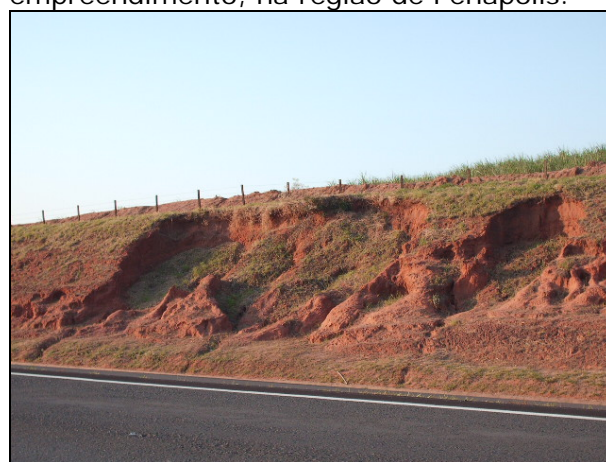
Figura 8.1.2.4-9. Detalhe de sulcos erosivos em talude da Rodovia Marechal Rondon (SP-300), no município de Guarantã.
