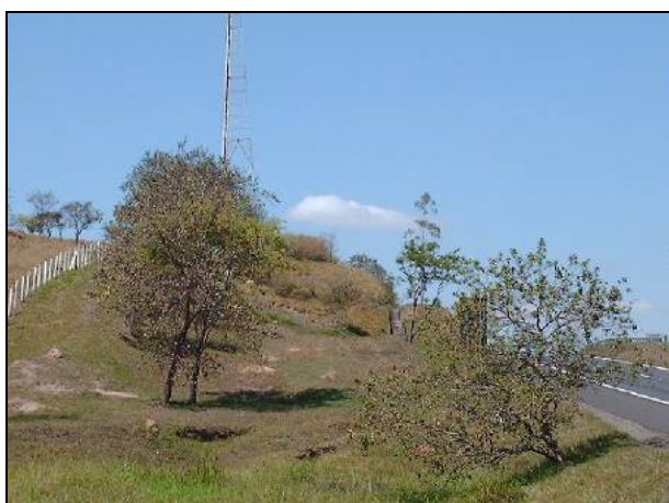
Figura 8.1.3.2-161. Trecho onde o poliduto irá passar em corte da rodovia SP-310. Afloramento de solo arenoso da Formação Pirambóia, material com média capacidade de suporte e grau de escavabilidade de material branco.
