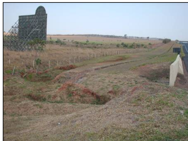
Figura 8.1.3.2-246. Detalhe da travessia em galeria de afluente do Rio Preto (travessia 76), que apresenta-se parcialmente aterrado. Possível interceptação do nível de água subterrâneo e presença de sedimentos aluvionares inconsolidados abaixo do aterro.
