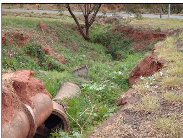
Figura 8.1.2.5-37. Detalhe de processo erosivo desconfinando tubulação de água pluvial em afluente do Córrego Santa Rita, na área urbana de Fernandópolis, próximo da travessia do poliduto da pista Sul para Norte (SP-320 - Rodovia Euclides da Cunha).
