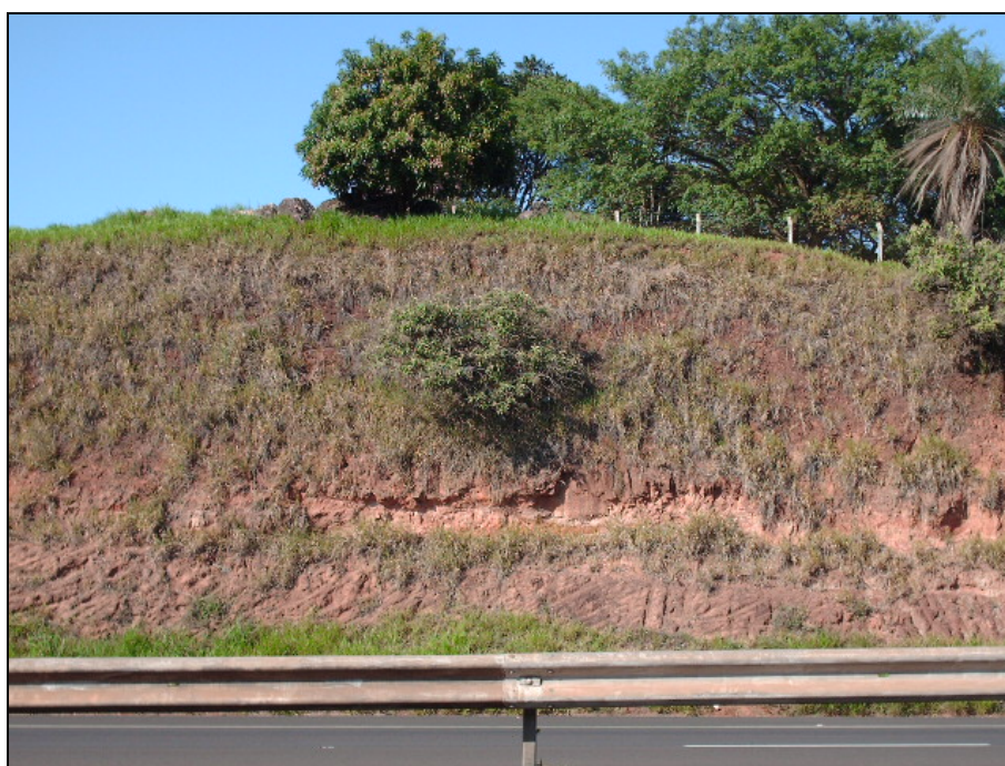
Figura 8.1.2.1-10. Feições de instabilidade em talude da SP-310, Pista Sul (ADA). Possível área de empréstimo (763.438E/7.611.884N).
