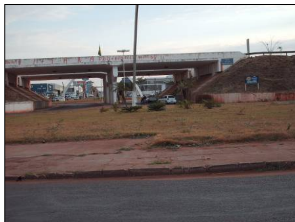
Figura 8.1.3.2-482. Detalhe da travessia de Afluente do Córrego São Pedro em galeria sob viaduto da SP-300 (Marechal Rondon).
