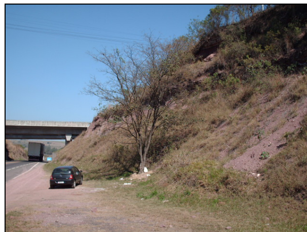
Figura 8.1.2.4-15. Detalhe de local com ocorrência de rolamento de blocos e escorregamento em siltito e arenito silicificado da Formação Corumbataí, próximo a travessia da SP-310 (Washington Luis) com a SP-191.
