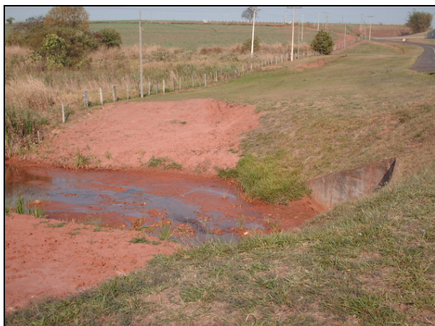
Figura 8.1.2.5-24. Detalhe da travessia Córrego do Taquari, que encontra-se assoreada devido ao aporte de sedimentos provenientes dos sedimentos arenosos da Formação Adamantina.
