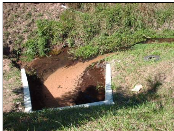
Figura 8.1.3.2-199. Detalhe da travessia do Córrego dos Macacos ou Conde, na SP-310, onde pode-se observar a presença de obra de contenção das margens, pequeno depósito de assoreamento e ausência completa de vegetação ciliar, em local de alta suscetibilidade a erosão.
