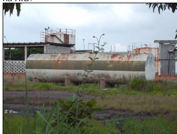
Figura 8.1.3.2-12. Empresa Transbittar com tanques de armazenamento sem caixa de contenção. Potencial área contaminada na AID.
