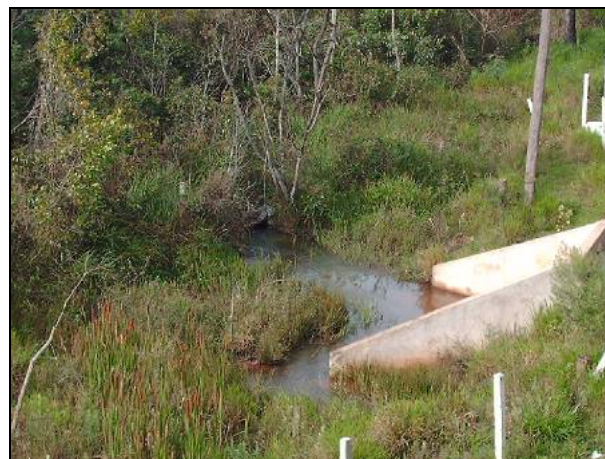
Figura 8.1.3.2-319. Detalhe da travessia de Afluente do Córrego da Água Branca, onde nota-se depósito de assoreamento.
