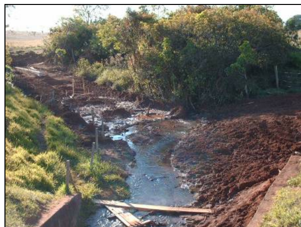
Figura 8.1.3.2-215. Travessia do Córrego Santa Maria Madalena, onde está sendo implantada galeria de drenagem. Pode-se observar que as margens apresentam certa estabilidade devido a presença de vegetação ciliar.
