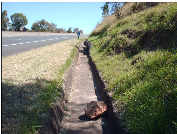
Figura 9.3-17. Detalhe de bloco de basalto que rolou do talude nas margens da Rodovia SP-310 (Washington Luis), na Serra dos Padres, atingindo o sistema de drenagem superficial.
