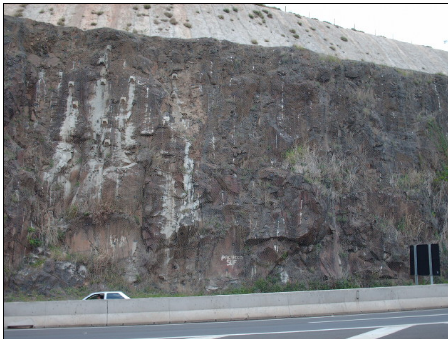
Figura 8.1.2.1-13. Trecho de paredão rochoso na pista Leste da Rodovia SP-225 (Rodovia Engenheiro Paulo Nilo Romano), onde há ocorrência de queda de blocos.
