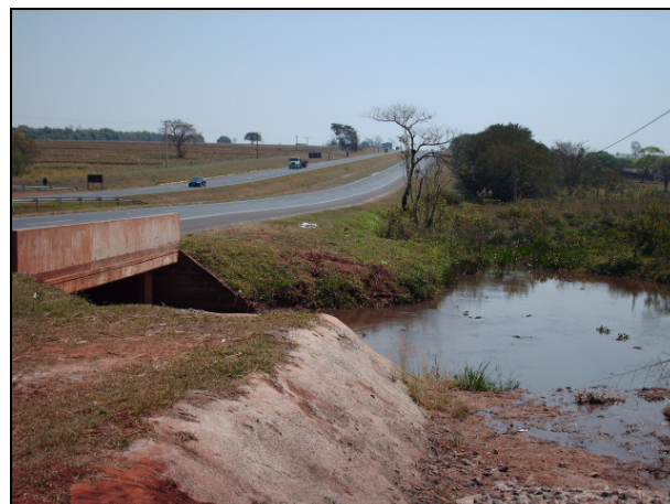
Figura 8.1.2.5-22. Detalhe da travessia do Ribeirão do Lajeado no município de Araraquara, que apresenta obras de impermeabilização nas margens e pequeno depósito de assoreamento.
