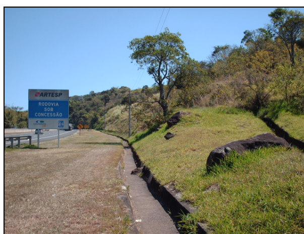
Figura 9.3-5. Local suscetível a ocorrência de rolamento de blocos de basalto e arenito silicificado, nas margens da SP-310 (Rodovia Washington Luis), na Serra dos Padres.
