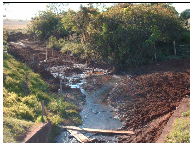
Figura 8.1.2.5-18. Travessia de drenagem. Observa-se movimentação de terra para implantação de galeria de drenagem. As margens apresentam-se estáveis devido a presença de vegetação ciliar.
