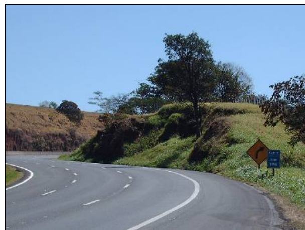
Figura 8.1.3.2-174. Local de afloramento de basalto bem no limite do acostamento da rodovia, problemas com escavabilidade, sendo sugerido a realização de furo direcional para evitar o desmonte de grande volume de material rochoso.
