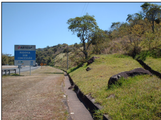
Figura 8.1.2.4-14. Local suscetível a ocorrência de rolamento de blocos de basalto e arenito silicificado, nas margens da SP-310 (Rodovia Washington Luis), na Serra dos Padres.
