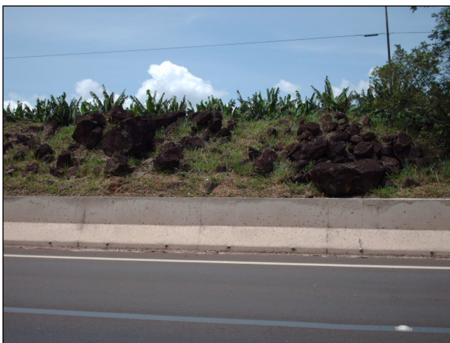
Figura 8.1.2.1-12. Presença de blocos rochosos de diabásio em talude na Rodovia SP-225 (Rodovia Engenheiro Paulo Nilo Romano). Local potencial para rolamento de blocos.
