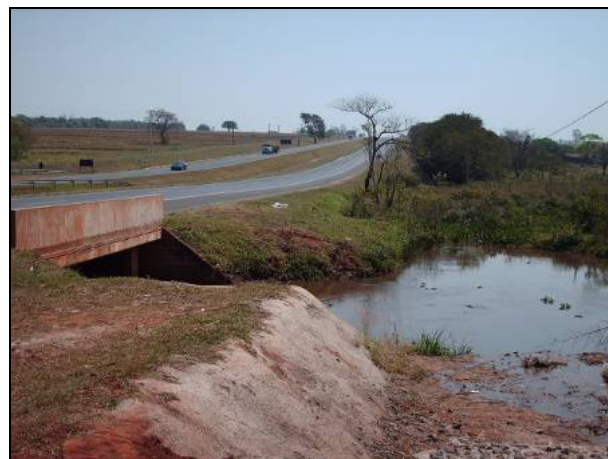
Figura 8.1.3.2-232. Detalhe da travessia do Ribeirão do Lajeado no município de Araraquara, que apresenta obras de contenção das margens e pequeno depósito de assoreamento.
