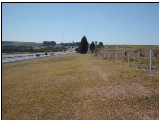
Figura 8.1.3.2-182. Vista geral do início do trecho, onde ocorre solo arenoso da Formação Botucatu. Pode-se observar o relevo plano no topo da Cuestas. Material brando para escavabilidade, com média capacidade de suporte e de alta suscetibilidade a erosão, contudo não foi identificado nenhum ponto de erosão instalado na ADA nesse trecho.
