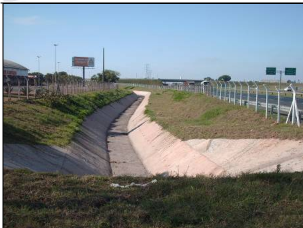
Figura 8.1.3.2-157. Detalhe da galeria de drenagem da água pluvial em trecho superficial localizado dentro da ADA.
