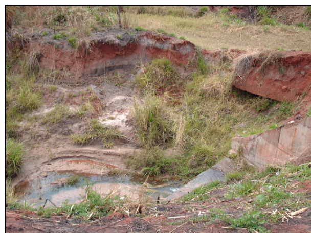
Figura 8.1.2.5-35. Travessia do Córrego do Galão e de seu afluente no município de Fernandópolis, onde ocorre intenso processo de erosão das margens e assoreamento do leito por sedimentos. A galeria de drenagem e o talude da rodovia estão sendo instabilizados pelo processo (SP-320 - Rodovia Euclides da Cunha, pista norte).
