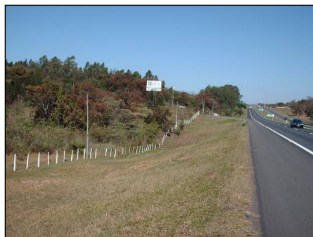
Figura 8.1.3.2-200. Detalhe geral da travessia do Córrego dos Macacos ou Conde, descrito na figura anterior, onde pode-se notar a ocorrência de aterro da rodovia cobrindo a planície aluvionar.
