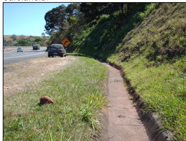
Figura 8.1.2.4-13. Detalhe de local com ocorrência de rolamento de blocos nas margens da SP-310 (Rodovia Washington Luis), na Serra dos Padres.
