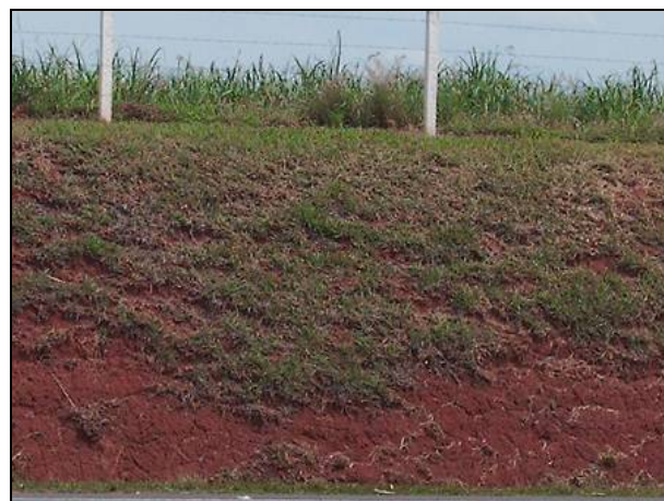
Figura 8.1.3.2-405. Perfil de alteração de solo da Formação Serra Geral nas margens da travessia do Rio Tietê. Problemas de escavabilidade.
