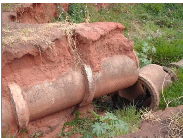
Figura 8.1.3.2-278. Detalhe de processo erosivo em tubulação de água pluvial próximo da travessia da pista Sul para Norte, citado na figura anterior.
