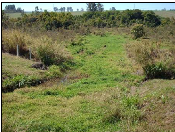
Figura 8.1.3.2-191. Travessia do Córrego das Cobras (213.022E/7.544.932N) que poderá ser feita por escavação direta. Praticamente não há planície aluvionar nessa travessia, mas haverá interceptação do nível de água subterrâneo. Pequeno trecho (menor de 50 metros), onde pode ocorrer material de baixa capacidade de suporte.
