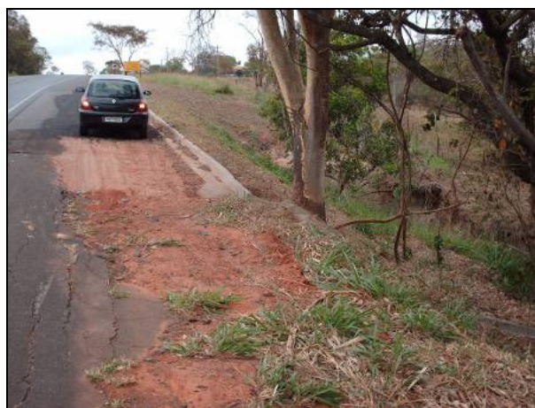
Figura 8.1.3.2-263. Detalhe da travessia do Ribeirão Bonito (travessia 14) descrita na figura anterior, onde nota-se que o talude da rodovia SP-320 foi afetado, inclusive atingindo o acostamento.
