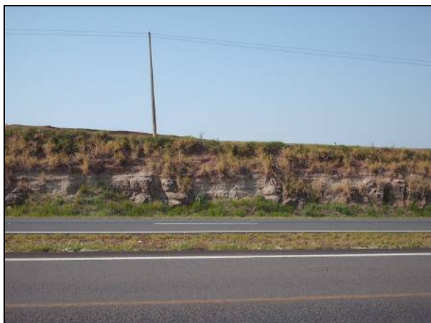
Figura 8.1.3.2-454. Afloramento rochoso (arenitos e siltitos), por aproximadamente 500m (585.210E/7.630.618N) – rocha branda a dura.
