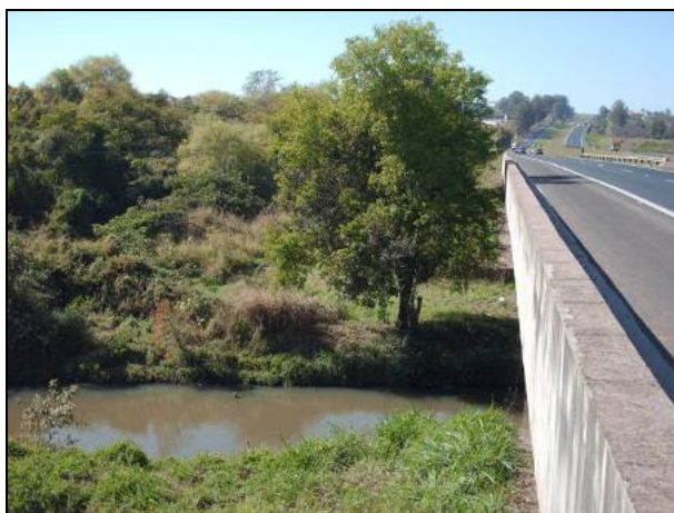
Figura 8.1.3.2-158. Detalhe da travessia do Rio Corumbataí no município de Rio Claro, onde as águas apresentam uma grande carga de sedimentos em suspensão, mas sem ocorrência de depósitos de assoreamento e processos erosivos, sendo que as margens estão relativamente estabilizadas nesse trecho. Presença de sedimentos inconsolidados (areias, argilas e cascalhos) de baixa capacidade de suporte e grau de escavabilidade friável e fluente. Recomenda-se o uso na travessia de furo direcional.
