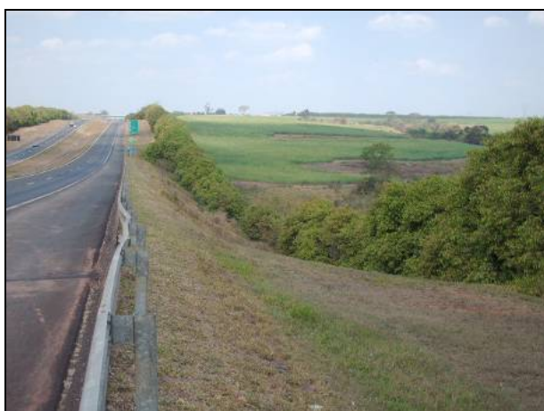
Figura 8.1.3.2-237. Detalhe da travessia Córrego da Contribuição, que será feito no aterro da rodovia, com possíveis problemas de erosão durante os trabalhos de operação do polduto (travessia 8).
