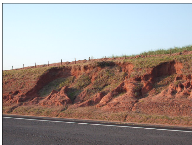
Figura 9.3-3. Detalhe de sulcos erosivos em talude da Rodovia Marechal Rondon (SP-300), no município de Guarantã.
