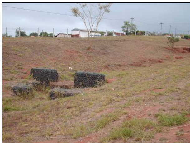
Figura 8.1.3.2-260. Detalhe de obras de contenção de erosão nas margens do Ribeirão Jataí (travessia 12), onde pode-se observar a ocorrência de sulcos erosivos, município de Tanabi
