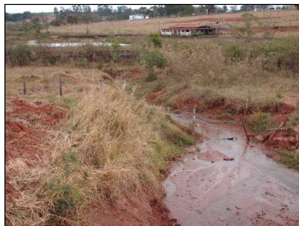
Figura 8.1.3.2-267. Travessia do Córrego das Paineiras (travessia 25) no município de Votuporanga, onde nota-se intenso assoreamento no leito da drenagem (SP-320 - Rodovia Euclides da Cunha, pista norte). Ocorrência de sedimentos aluvionares inconsolidados de baixa capacidade de suporte e provável interceptação do nível de água subterrâneo.
