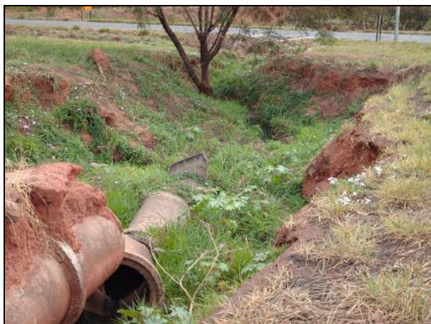
Figura 8.1.3.2-277. Detalhe de processo erosivo na tubulação de água pluvial em aflente do Córrego Santa Rita (travessia 47) na área urbana de Fernandópolis, próximo da travessia do poliduto da pista Sul para Norte (SP-320 - Rodovia Euclides da Cunha).
