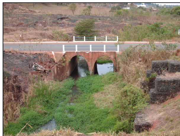
Figura 8.1.2.5-27. Detalhe da travessia do Ribeirão Jataí, no município de Tanabi, que apresenta obras para controle de erosão com gabiões em suas margens. O leito da drenagem está intensamente assoreado.
