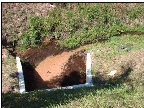
Figura 8.1.2.5-17. Detalhe da travessia de drenagem, na SP-310, onde se observa pequeno depósito de assoreamento e ausência completa de vegetação ciliar, em local de alta suscetibilidade a erosão.
