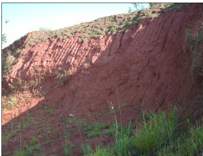
Figura 9.3-14. Presença de evidências de movimentação em talude da SP-310, Pista Norte (AID), como degraus de abatimento e cicatriz de escorregamento
