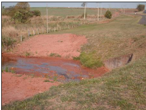
Figura 8.1.3.2-244. Detalhe da travessia Córrego do Taquari (travessia 66), que apresenta-se totalmente assoreado proveniente de sedimentos arenosos da Formação Adamantina.
