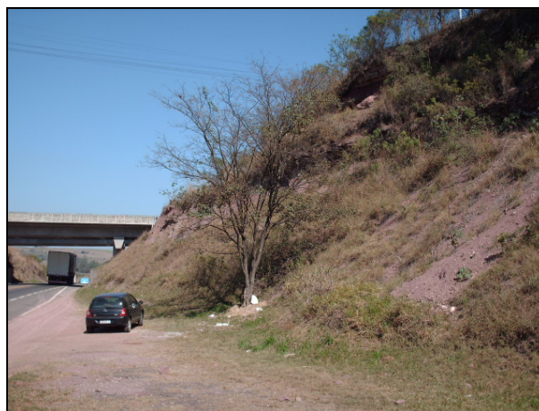
Figura 9.3-6. Detalhe de local com ocorrência de rolamento de blocos e escorregamento, próximo a SP-310 (Washington Luis) com a SP-191.
