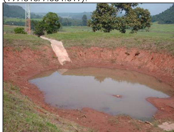
Figura 8.1.3.2-325. Detalhe de sistema de contenção de água pluvial da Rodovia SP-225.
