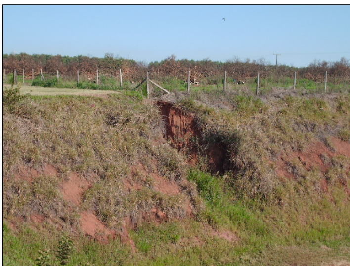
Figura 9.3-15. Feições de instabilidade em talude na SP-310, Pista Norte (AID).
