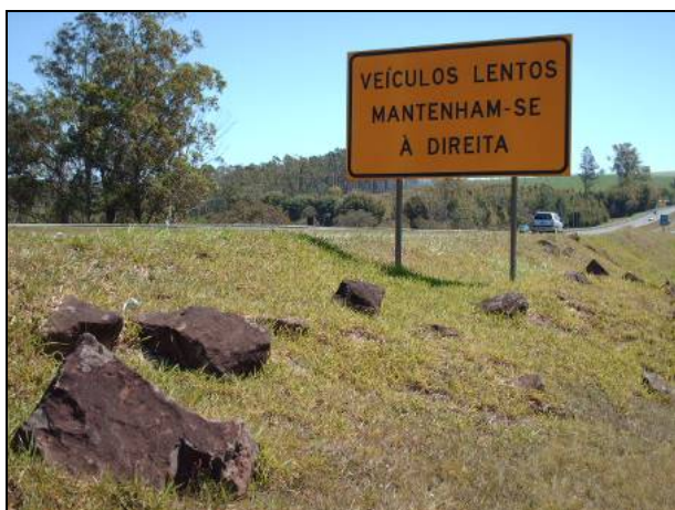
Figura 8.1.3.2-162. Detalhe do aterro da rodovia com blocos rochosos de diabásio que estão sobre sedimentos inconsolidados aluvionares. Possíveis problemas de escavabilidade e presença de nível de água acima de 2 metros de profundidade.
