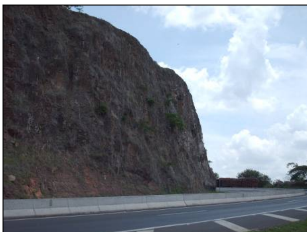
Figura 8.1.3.2-380. Trecho de paredão na pista Leste da Rodovia SP-225, onde há ocorrência de queda de blocos. Foram implantadas telas de segurança para controle do citado processo.
