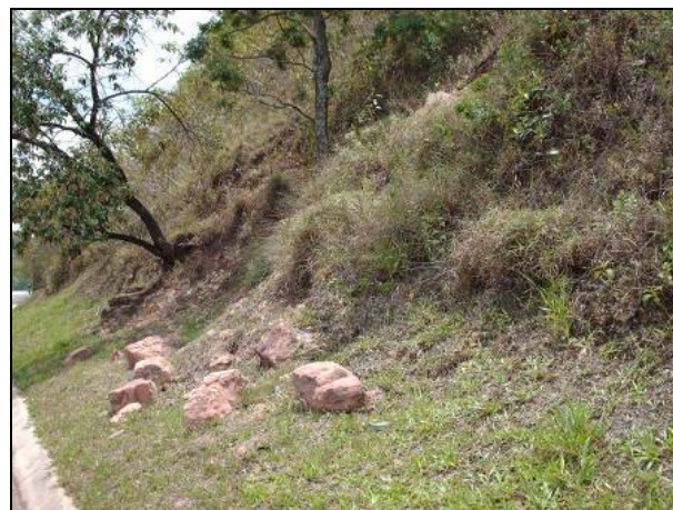
Figura 8.1.3.2-377. Área com ocorrência de rolamento e queda de blocos de diabásio e arenito no talude da Rodovia SP-225 (pista oeste). Local de riscos ocorrência de escorregamento (trecho: 774.289E/7.537.138N a 771.917E/7.536.886N).
