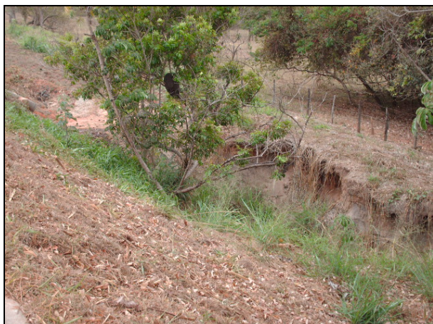
Figura 8.1.2.5-28. Detalhes do processo erosivo de ravinamento nas margens da travessia do Ribeirão Bonito no município de Tanabi (SP-320 -Rodovia Euclides da Cunha, pista norte).
