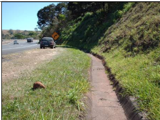
Figura 8.1.3.2-179. Detalhe de local com ocorrência de rolamento de blocos rochosos nas margens da SP-310 (Rodovia Washington Luis) na Serra dos Padres. Trecho muito suscetível a movimentos de massa.
