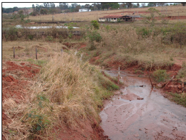
Figura 8.1.2.5-32. Travessia do Córrego das Paineiras no município de Votuporanga, onde se observa intenso assoreamento no leito da drenagem (SP-320 - Rodovia Euclides da Cunha, pista norte).
