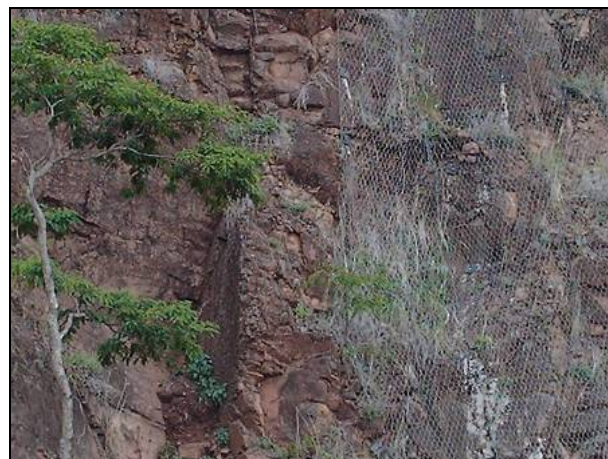
Figura 8.1.3.2-381. Detalhe das telas de segurança implantadas pela concessionária da rodovia, em trecho de paredão na pista Leste da Rodovia SP-225, onde há ocorrência de queda de blocos.
