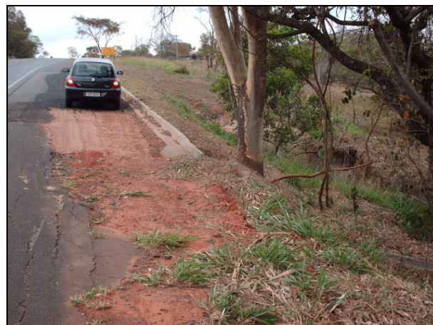
Figura 8.1.2.5-30. Detalhe da travessia Ribeirão Bonito descrita na figura anterior, onde nota-se que o talude da rodovia SP-320 foi afetado, inclusive atingindo o acostamento.
