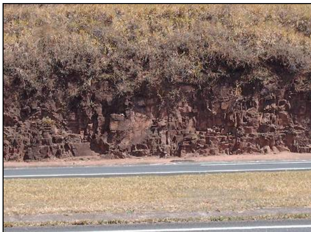
Figura 8.1.3.2-175. Detalhe do basalto que aflora na Serra dos Padres no limite com o acostamento da rodovia. Necessidade de realizar furo direcional
