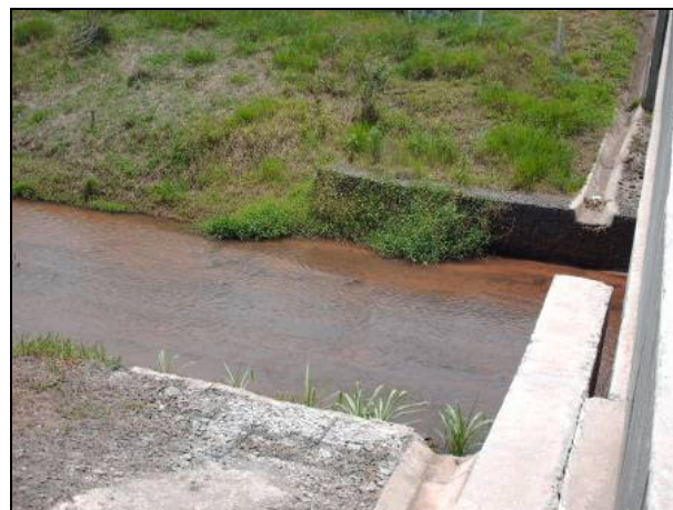
Figura 8.1.3.2-390. Travessia do Ribeirão do Peixe, onde há obra de canalização e presença de sedimentos arenosos.
