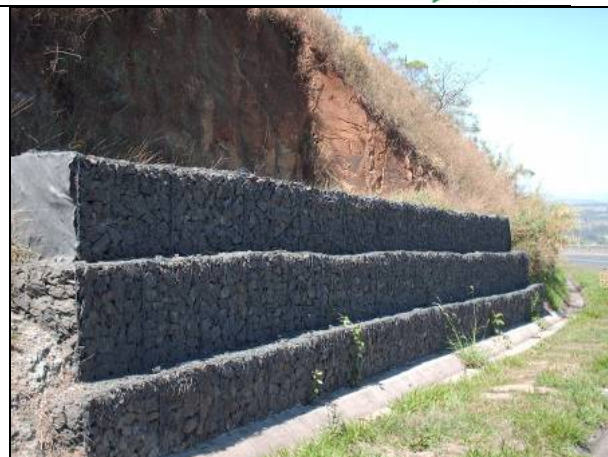
Figura 8.1.3.2-181. Detalhe de muro de arrimo feito de gabião para contenção de escorregamentos nas margens da Rodovia SP-310 (Washington Luis), na Serra dos Padres. Área muito suscetível a movimentos de massa.
