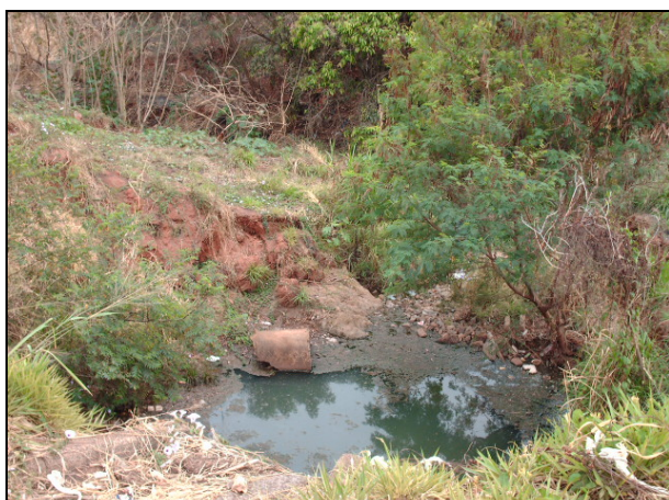
Figura 8.1.2.5-33. Travessia do afluente do Córrego Marinheiro, no município de Votuporanga, que apresenta processos intensos de erosão das margens e assoreamento (SP-320 - Rodovia Euclides da Cunha, pista norte).
