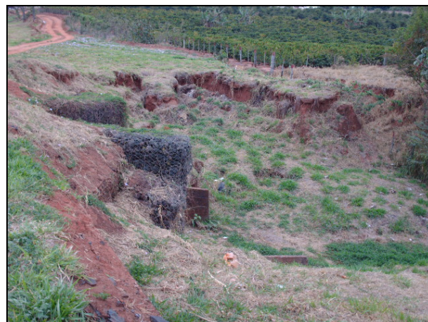
Figura 8.1.2.5-26. Detalhe da travessia Córrego Perobinha no município de Tanabi, onde se observa processo de erosão nas margens e estrutura de gabião para contenção do ravinamento.
