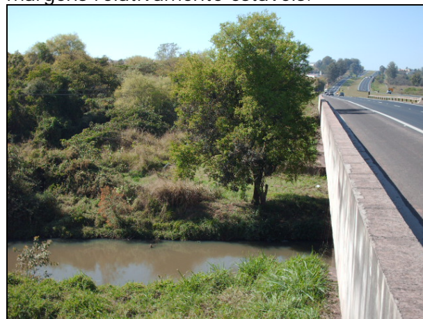
Figura 8.1.2.5-15. Detalhe da travessia do Rio Corumbataí no município de Rio Claro, onde as águas apresentam uma grande carga de sedimentos em suspensão, mas sem ocorrência de depósitos de assoreamento e processos erosivos, sendo que as margens estão relativamente estabilizadas.
