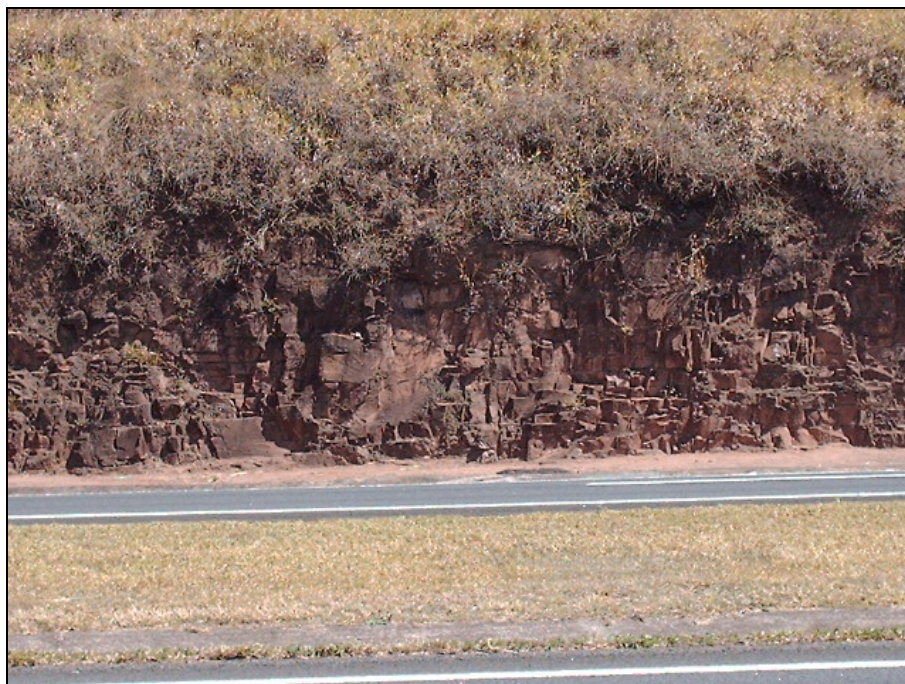
Figura 8.1.2.2-15. Afloramento de basalto e diabásio da Formação Serra Geral, na Serra dos Padres, onde pode-se observar a presença de blocos rochosos instáveis com alta suscetibilidade de queda e rolamento dos mesmos para a rodovia.
