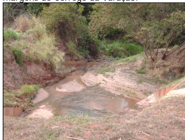
Figura 8.1.3.2-271. Detalhe da travessia do Córrego Galão (travessia 44), com problemas de erosão das margens, inclusive atingindo galeria de drenagem, e depósito de assoreamento em seu leito.
