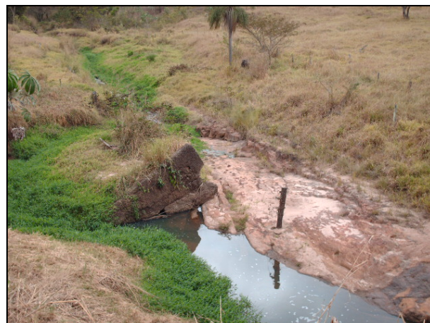
Figura 8.1.2.5-34. Travessia do Córrego da Varação, que apresenta sedimentos assoreando seu leito e um grande bloco de concreto obstruindo parcialmente seu fluxo (SP-320 - Rodovia Euclides da Cunha, pista norte).
