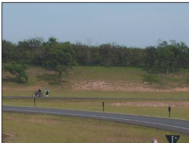
Figura 8.1.3.2-321. Processos de erosão laminar e sulcos no talude da rodovia da SP-225, Rodovia Engenheiro Paulo Nilo Romano (214.685/ 7.540.634).
