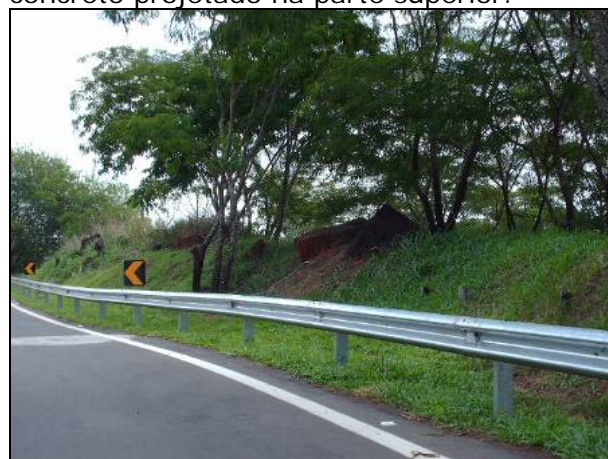
Figura 8.1.3.2-383. Presença de blocos de diabásio em trecho projetado para passagem do poliduto na Serra de Brotas/Dois Córregos. Problemas de escavabilidade e movimentos de massa.
