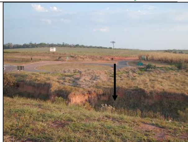
Figura 8.1.3.2-449. Travessia do Córrego Congonhas no município de Pirajuí, onde há uma boçoroca, ocasionando assoreamento a jusante da drenagem.
