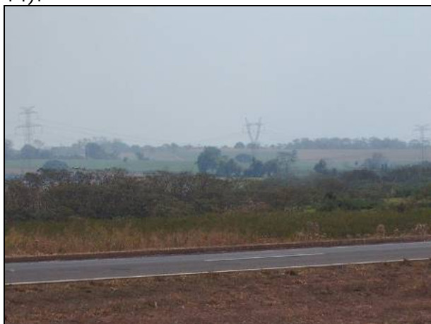
Figura 8.1.3.2-241. Detalhe da travessia 16 Rio São Lourenço, onde há uma grande planície aluvionar com cerca de 300 metros. Presença de sedimentos de baixa capacidade de suporte e interceptação do nível de água subterrâneo, sendo recomendado o uso de furo direcional (travessia 17).
