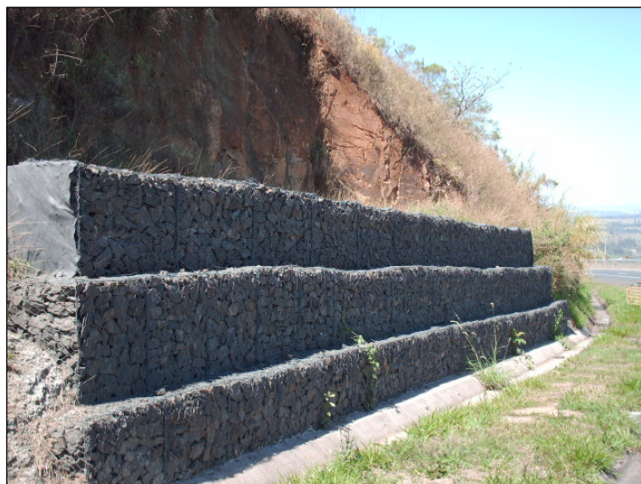
Figura 9.3-12. Detalhe de muro de arrimo feito de gabião para contenção de escorregamentos nas margens da Rodovia SP-310 (Washington Luis), na Serra dos Padres.
