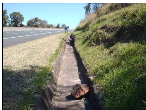
Figura 8.1.3.2-178. Detalhe de bloco de basalto que rolou do talude nas margens da Rodovia SP-310 (Washington Luis), na Serra dos Padres, atingindo o sistema de água pluvial. Pode-se notar que em alguns locais há um estreitamento da faixa do poliduto, ficando muito próximo aos taludes suscetíveis a rolamento e queda de blocos, com riscos de acidentes.
