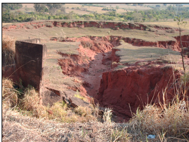
Figura 8.1.2.4-6. Processo erosivo (ravinamento) de grandes proporções ao lado da rodovia SP-300 (Rodovia Marechal Rondon), no município de Mirandópolis, afetando o sistema de dissipação de energia da água pluvial e controle de erosão implantado pela concessionária (ponto 492.732E/7.668.874N).
