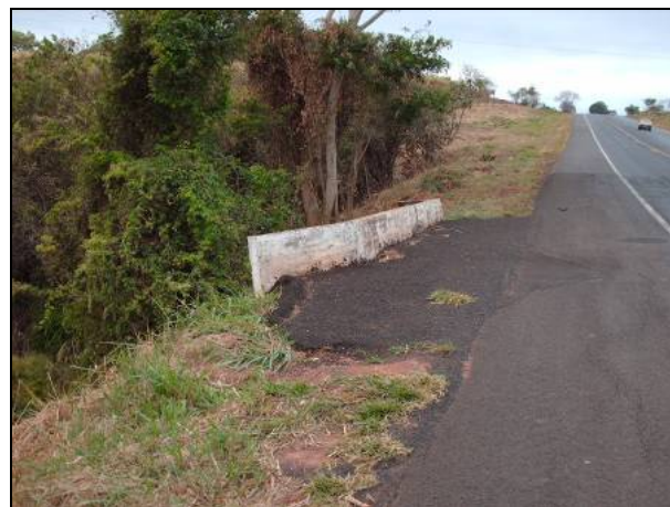
Figura 8.1.3.2-270. Detalhe de problemas de instabilidade do talude da rodovia devido a processos erosivos das margens do Córrego da Varação.
