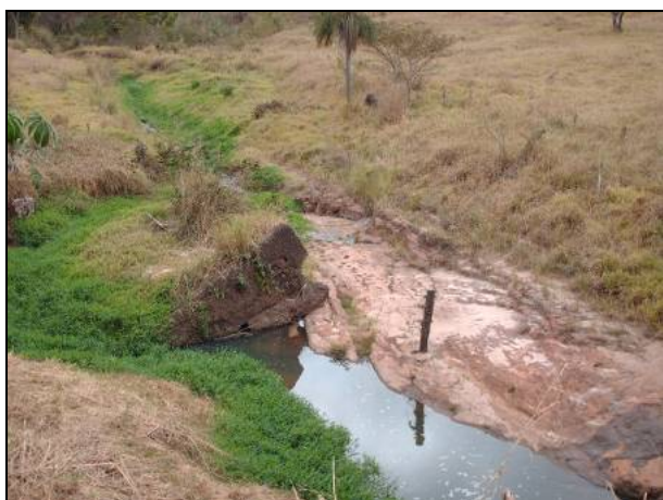
Figura 8.1.3.2-269. Travessia do Córrego da Varação (travessia 34), que tem blocos de concreto e sedimentos assoreando seu leito (SP-320 - Rodovia Euclides da Cunha, pista norte).
