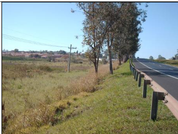
Figura 8.1.3.2-141. Vista da planície aluvionar do Rio Corumbataí no limite com a base do talude da Rodovia SP-310. Local onde há presença do gasoduto da Comgás dentro da ADA. Ocorrência de sedimentos aluvionares inconsolidados (areias e argilas) de baixa capacidade de suporte e grau de escavabilidade de fluente e friável. O nível de água será interceptado por estar a menos de 2,0 metros de profundidade. Recomenda-se furo direcional ou escavação direta, mas no caso da segunda opção, deve-se atentar para dificuldade de acesso de escavadeiras que podem atolar e até afundar devido a baixa capacidade de suporte dos sedimentos.
