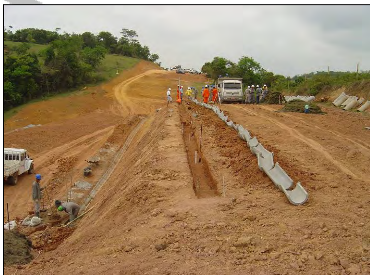
Foto II.4.3.3.1-11 - Dispositivos de drenagem/Sistema de canaletas longitudinais Fonte: PETROBRAS
