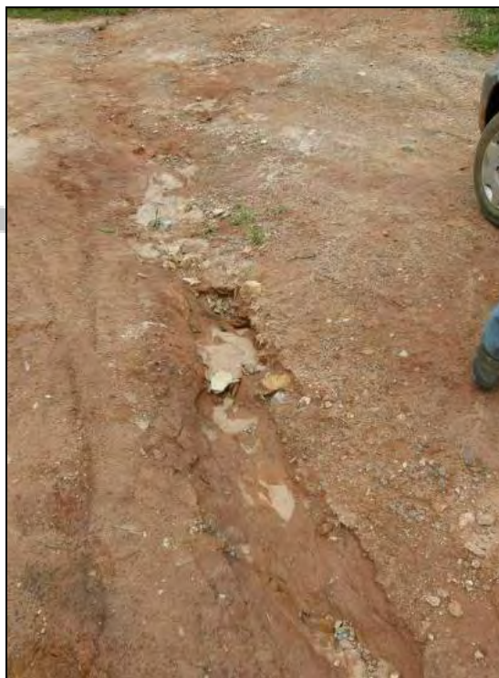
Foto V.1.5.2-17 - Erosão laminar evoluindo para sulcos em face da inexistência de sistema de drenagem em solos de natureza silto-arenosa. Coordenada 367419 / 7444860.
