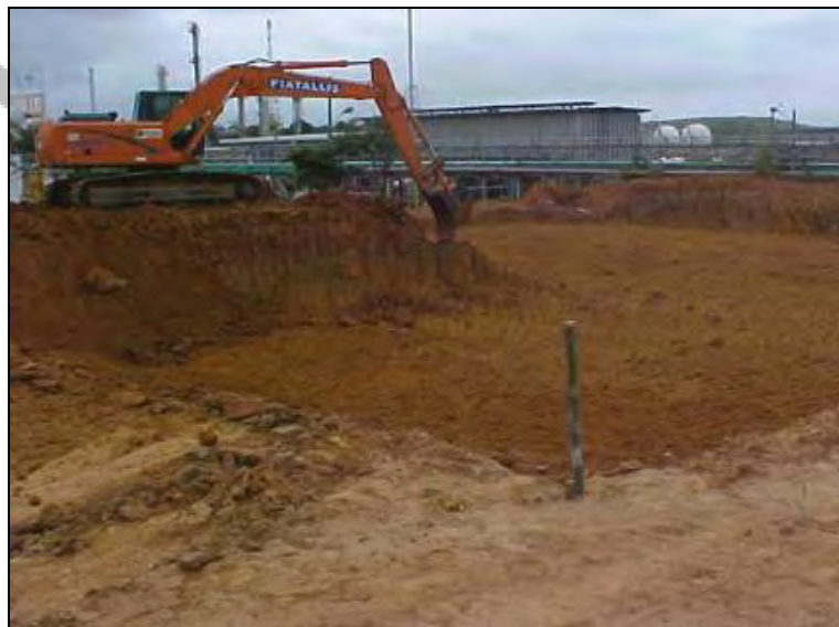
Foto II.4.3.4-1 - Execução de terraplenagem.
