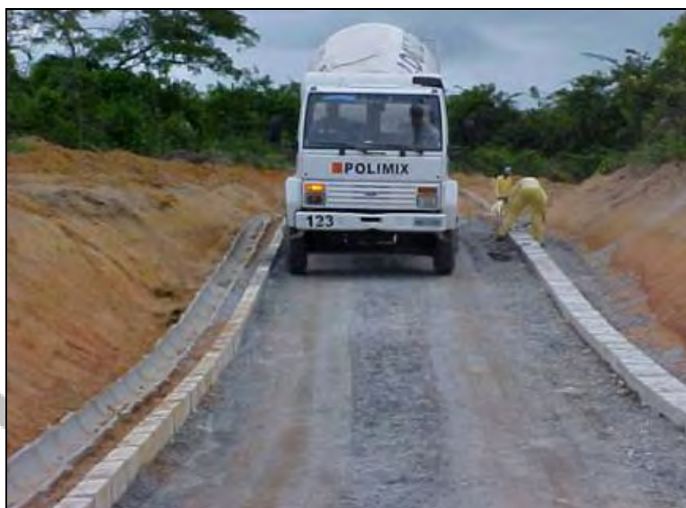
Foto II.4.3.4-4 - Execução da pavimentação.
