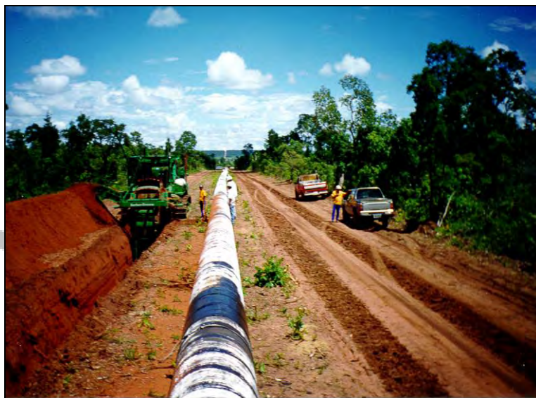
Foto II.4.3.3.1-7 - Abertura de vala utilizando uma valetadeira.
