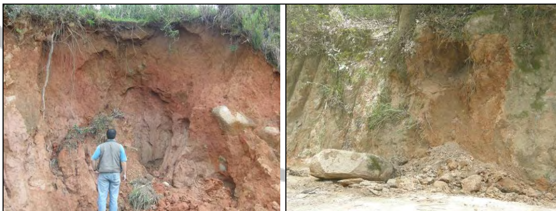
Fotos V.1.5.2-19 e V.1.5.2-20 - Alta susceptibilidade a erosão nos cambissolos e queda de bloco. Na Foto V.1.5.2-19 se observa o deslizamento dos horizontes B e C (este último mais susceptível - saprolítico) e na Foto V.1.5.2-20 queda de bloco por descalçamento, ambos em taludes de corte de estrada. Coordenadas 390730 / 7446245 e 296794 / 7482807.
