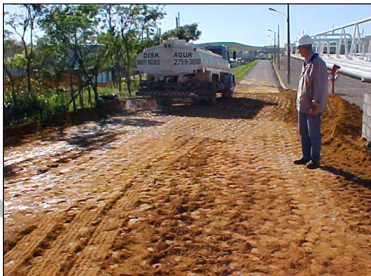
Foto II.4.4.1-3 - Aspersão de água para minimização de sólidos em suspensão. Fonte: PETROBRAS.
