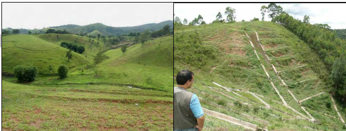
Fotos V.1.5.2-24 e 25 - Variação do método construtivo em face da existência de maior ou menor risco geotécnico. Na Foto V.1.5.2-24 duto sobre substrato granítico em relevo de morros com encostas mais suaves, com menor risco geotécnico. Foto V.1.5.2-25 área de relevo íngreme, com seqüência de canaletas longitudinais e transversais. Esta área é próxima ao contato dos granitos com os migmatitos do Complexo Pinhal em zona de falha. Coordenadas 361054 / 7446440 e 372526 / 7445289.
