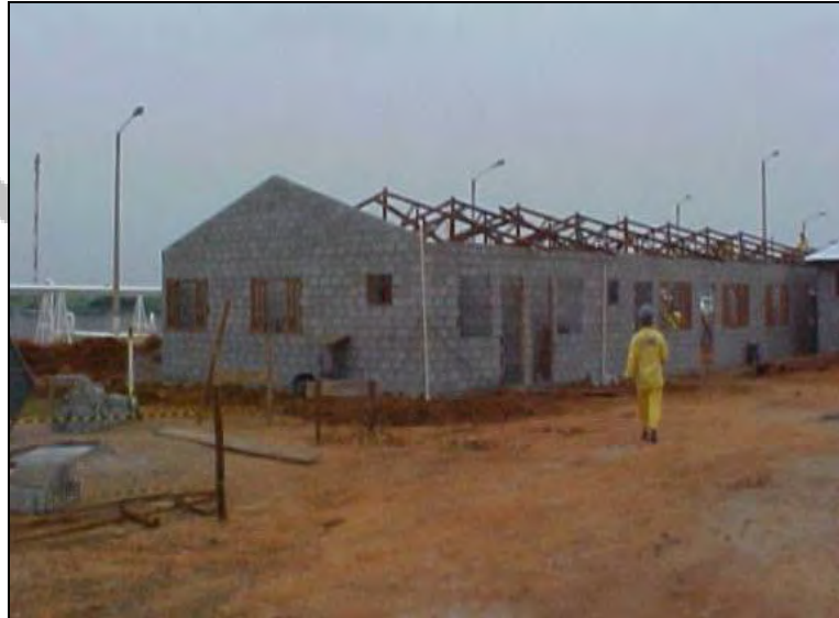
Foto II.4.3.4-3 - Ilustração de alvenarias, esquadrias e cobertura.
