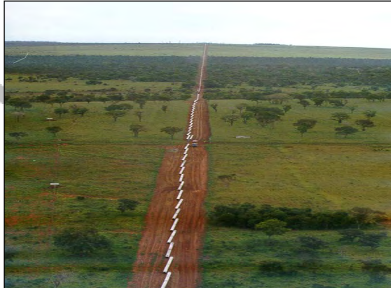
Foto II.4.3.3.1-2 - Desfile de tubos ao longo da faixa.
