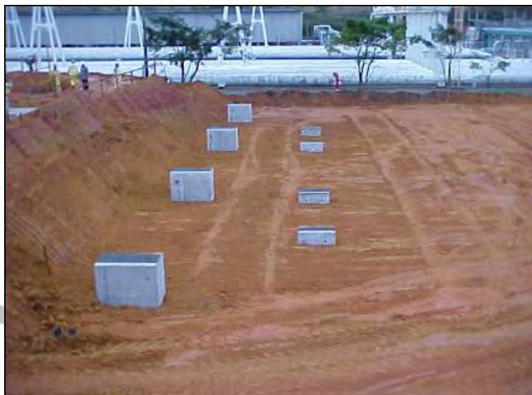
Foto II.4.3.4-2 - Execução de sapatas.
