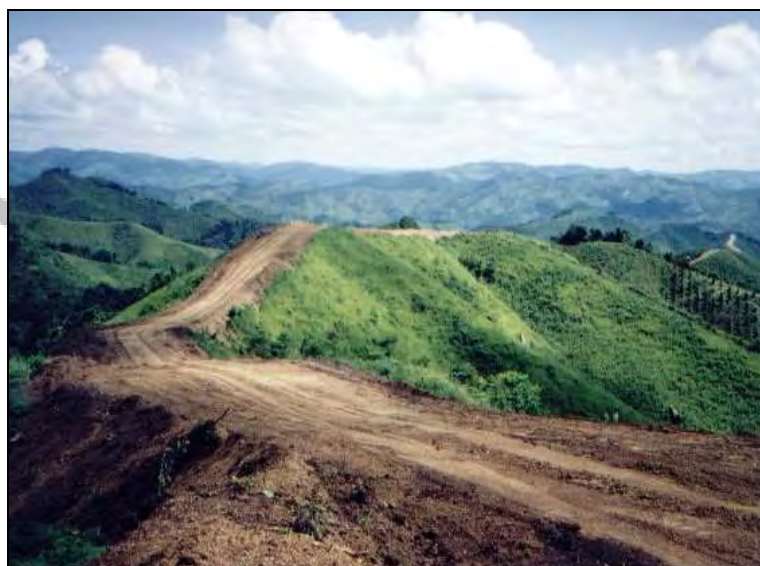
Foto II.4.3.3.1-1 - Limpeza e abertura da faixa. Fonte: PETROBRAS
