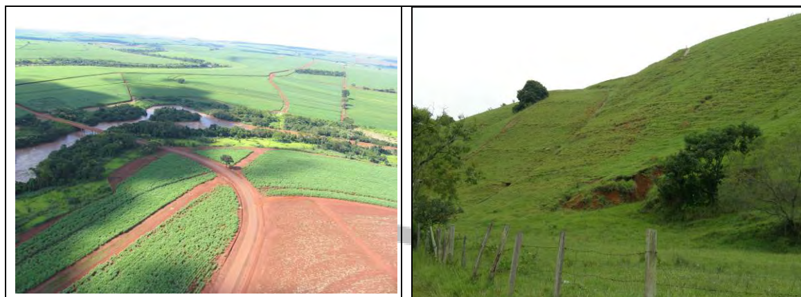
Foto V.1.5.3-3 -Traçado do duto desprovido de vegetação. Apesar de estar em área com pouca declividade, isto pode potencializar processos erosivos e assoreamento de drenagem Foto V.1.5.3-4 – Erosão ao lado do duto, tende a evoluir e atingir a faixa. Coordenadas 318508 / 7469779.
