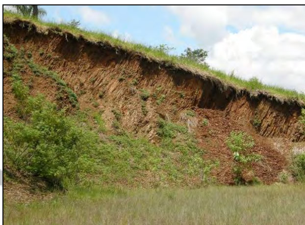
Foto V.1.5.2-6 - Rocha basáltica extremamente fraturada e com possibilidade de ocorrer argilas expansivas. Observe que o material se desagrega em pequenos fragmentos resultando em trechos com deslizamentos. Coordenada 236193 / 7598421.
