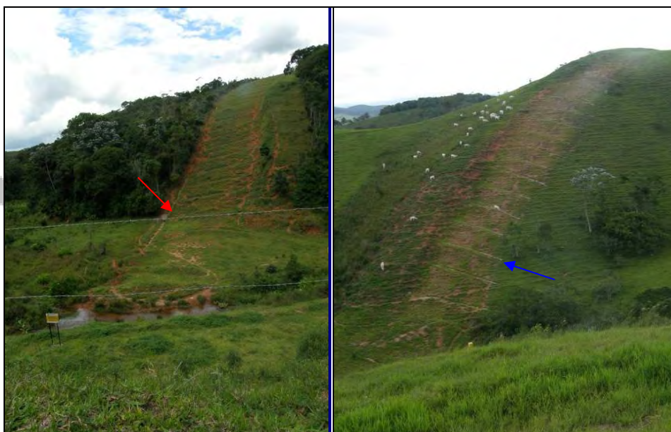
Fotos V.1.5.2-28 e 29 - Encostas íngremes com predomínio de canaletas transversais (seta azul). Na Foto V.1.5.2-28 escada e caixa de retenção na base do talude (lado esquerdo - seta vermelha). Coordenadas 379168 / 7445013 e 387579 / 7445850.
