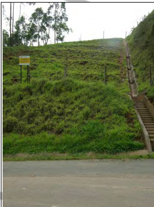
Foto VI.3.2.1-2 – Outro exemplo funcional de obras para controle de erosão. Canaletas longitudinais e transversais com escada de dissipação na base do talude. Coordenada 367419E / 7444860N.
