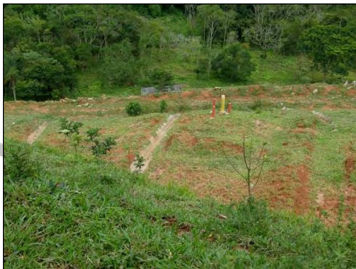
Foto V.1.5.2-27 - Canaletas longitudinais e transversais com escada de dissipação na base do talude. Coordenada 367419 / 7444860.
