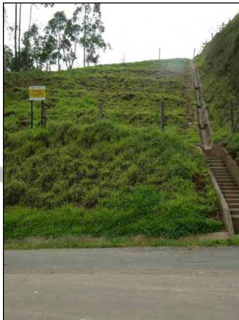
Foto V.1.5.2-26 - Canaletas longitudinais e transversais com escada de dissipação na base do talude. Coordenada 367419 / 7444860.
