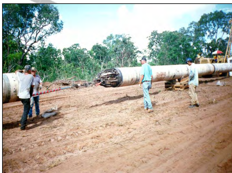
Foto II.4.3.3.1-4. Acoplamento de tubos. Fonte: PETROBRAS
