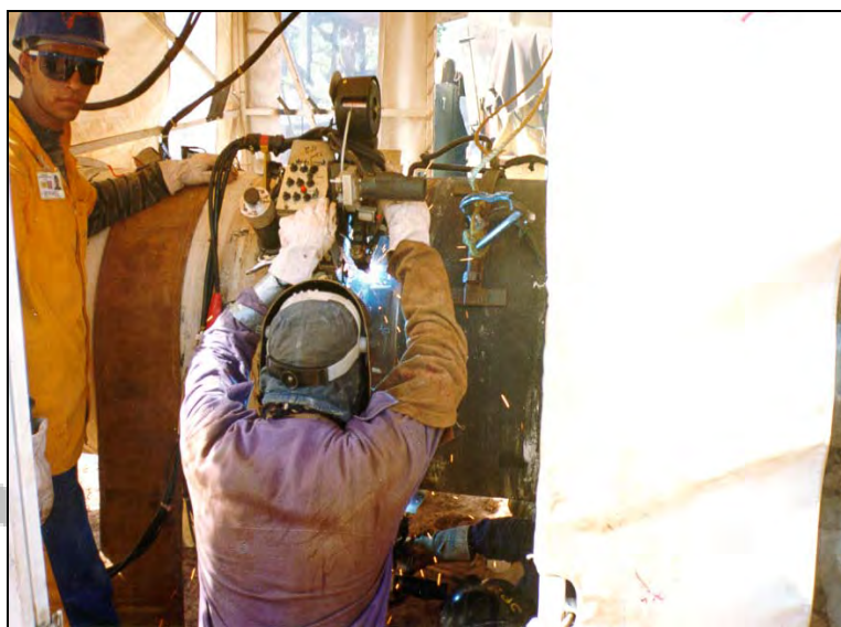
Foto II.4.3.3.1-5 - Soldagem da tubulação.
