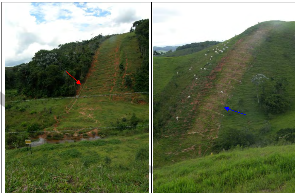
Fotos VI.3.2.1-3 - Encostas íngremes com predomínio de canaletas transversais (seta azul). Na escada e caixa de retenção na base do talude (lado esquerdo - seta vermelha). Coordenadas 379168 / 7445013 e 387579 / 7445850.
