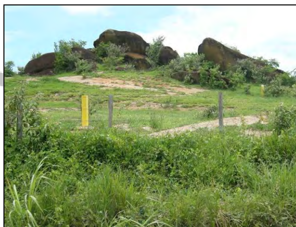
Foto V.1.5.2-13 - Duto em área que exige corte em materiais variando de 1ª a 3ª categoria, blocos precisam ser desmontados por explosivos. Coordenadas 298557 / 7481348.
