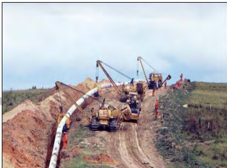
Foto II.4.3.3.1-9 - Abaixamento com Side Boom .
