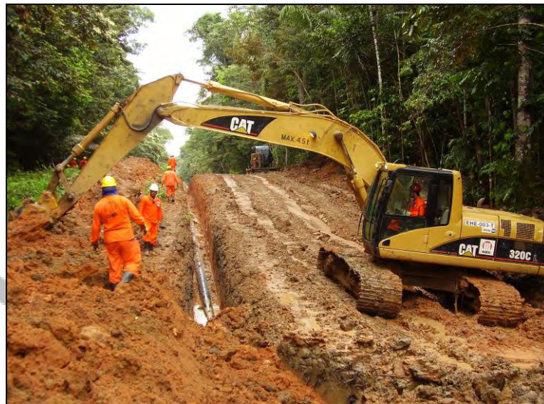
Foto II.4.3.3.1-10 - Cobertura da vala utilizando uma escavadeira hidráulica.
