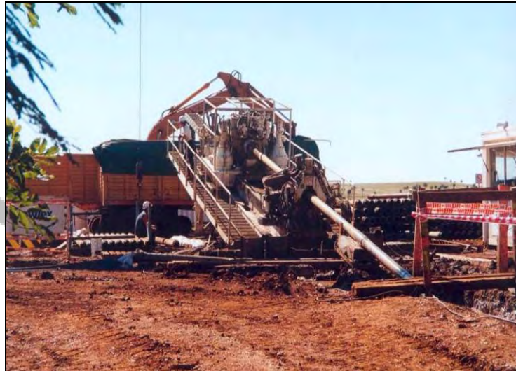
Foto II.4.3.3.2-2 - Equipamento utilizado na execução de furos direcionais. Fonte: PETROBRAS
