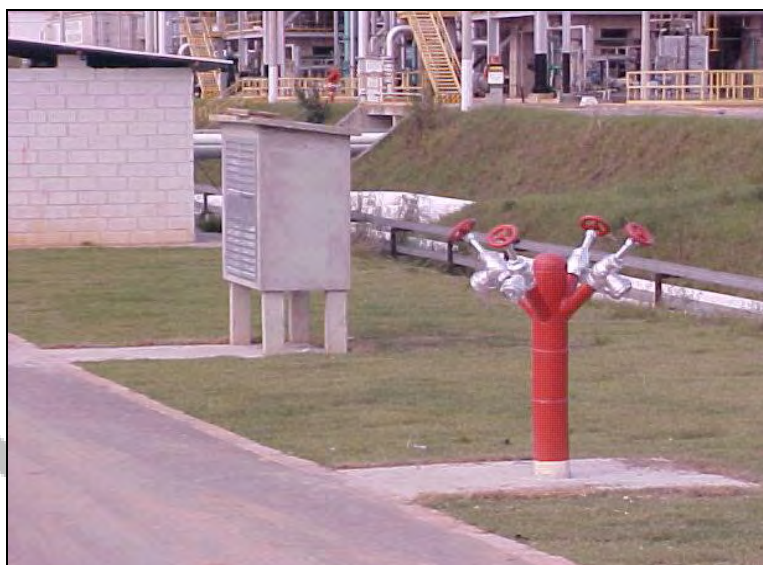
Foto II.4.3.4-8 - Sistema de proteção e combate a incêndio: hidrante e abrigo de mangueira de incêndio Fonte: PETROBRAS
