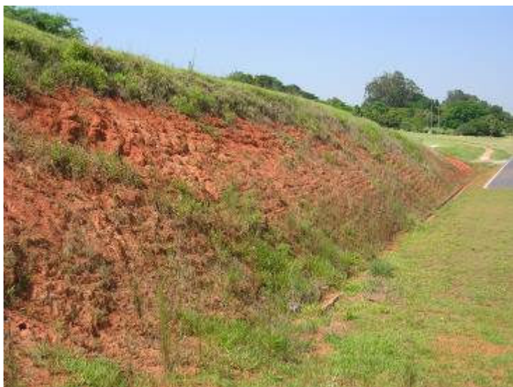
FOTO 13. Perfil de argissolo vermelho-amarelo encontrado na área. Talude de cerca de três metros de altura apresentando-se com boa estabilidade.
