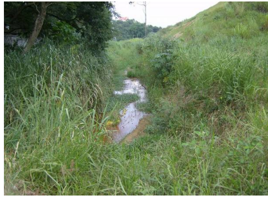
Foto 7.2.5.1.2. - Assoreamento do canal devido ao aporte de sedimentos.
