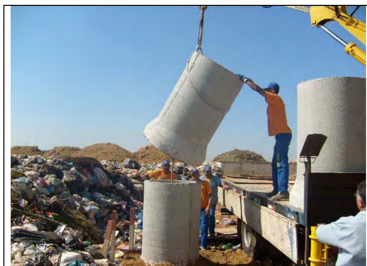
Foto III.3.3.19-2 – instrumentação geotécnica do maciço de resíduos: prolongamento do conjunto de tubos dos piezômetros – proteção com anéis de concreto
