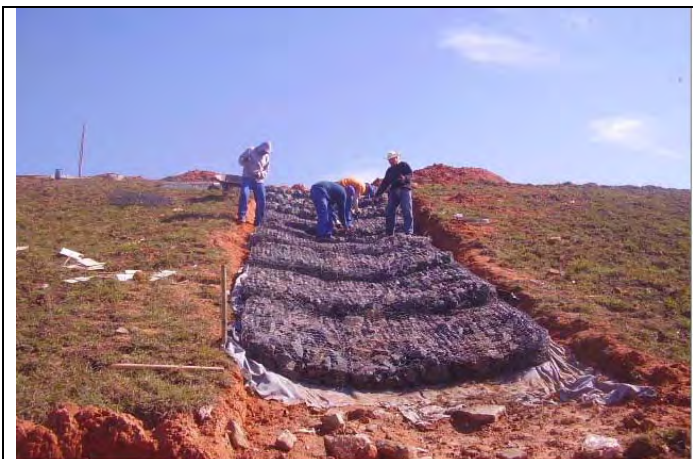
Figura III.2.5.3-2 – Sistema de drenagem superficial: descida d'água em talude com colchão Reno em execução.
