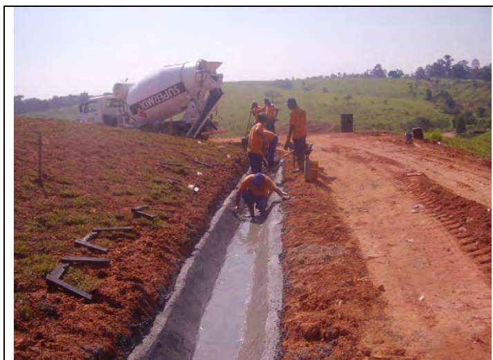
Figura III.2.5.3-1 – Sistema de drenagem superficial: canaletas de concreto de seção trapezoidal em execução.
