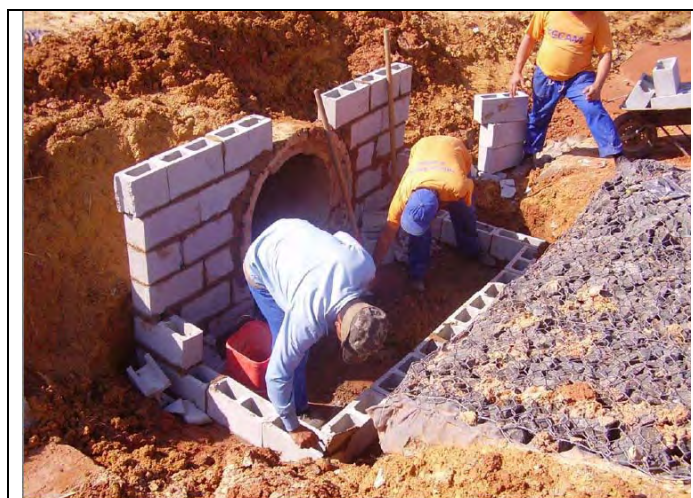
Figura III.2.5.3-3 – Execução de caixa de passagem – dispositivo de drenagem superficial do maciço
