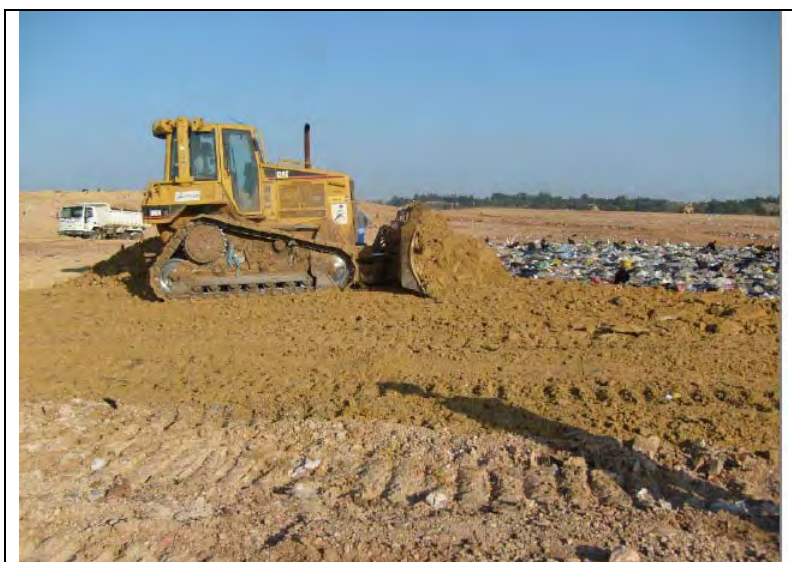
Foto III.3.3.8-1 – maciço de resíduos do aterro: operação dos serviços de cobertura diária dos resíduos com solos
