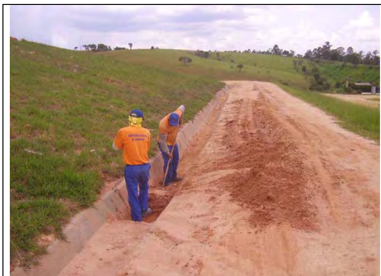
Foto III.3.3.19-5 – desassoreamento e limpeza das canaletas de concreto do sistema de drenagem superficial do maciço em execução
