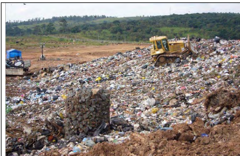
Foto III.3.3.7-1 - Área de descarga do aterro Delta A em operação: lançamento, espalhamento e compactação das camadas de resíduos do maciço do aterro
