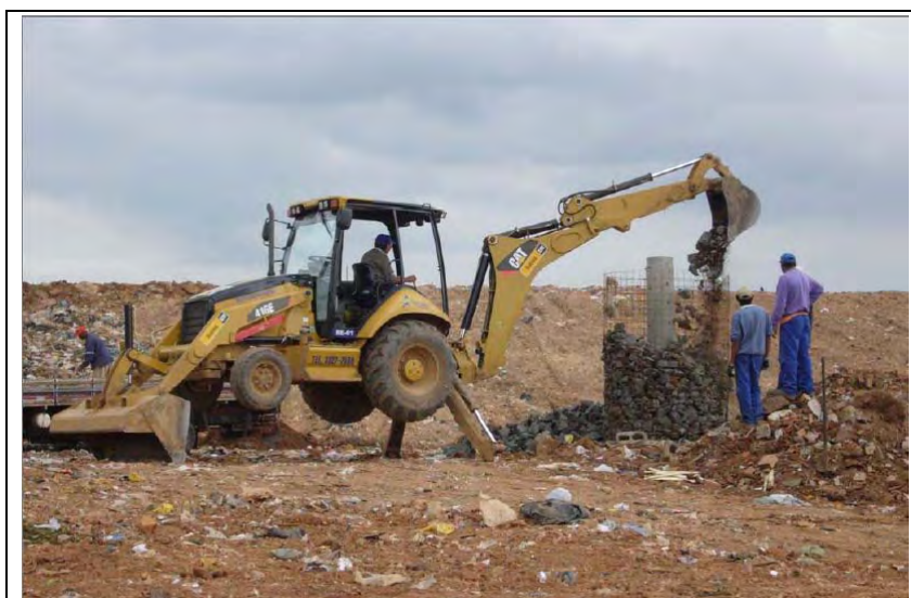
Foto III.3.3.9-1 – Execução de um dreno vertical de biogás
