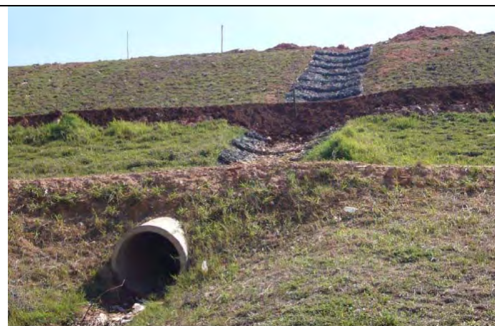
Figura III.2.5.3-3 – Descida d'água em talude com colchão Reno e dispositivos associados devidamente executados
