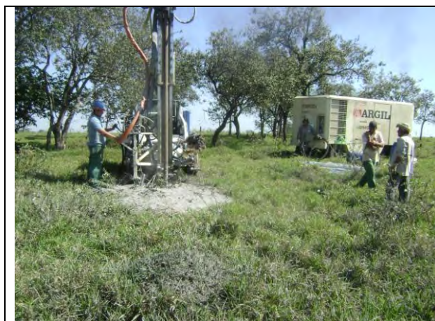
Foto IV.2.5.2.2-1 – Perfuração com utilização de Roto-pneumática
