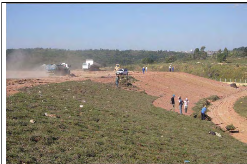
Foto III.3.3.11-1 – Serviços de aplicação de grama em placas para a proteção superficial dos taludes do maciço
