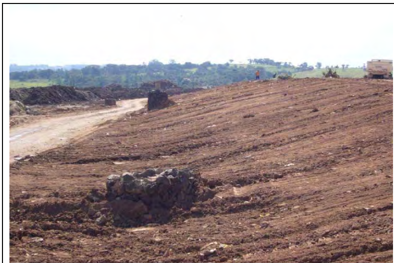
Foto III.3.3.8-2 – maciço de resíduos do aterro devidamente retaludado e coberto com solos e entulhos
