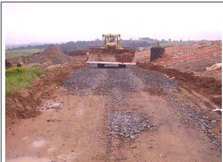
Foto III.3.3.19-3 – Serviços de execução e manutenção dos acessos internos à área de descarga do aterro
