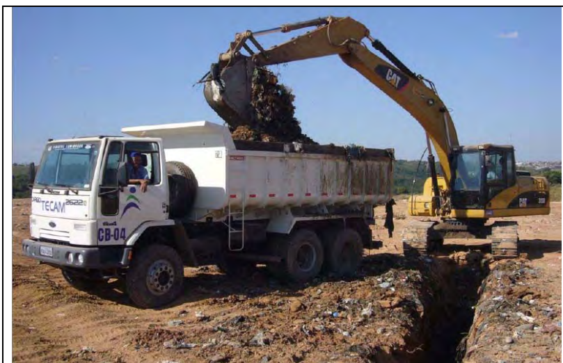
Figura III.2.5.2-2 – Dreno horizontal profundo em execução
