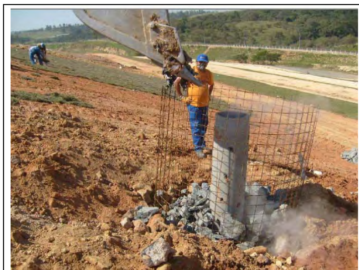
Figura III.2.5.2-1 – Dreno vertical de biogás em execução
