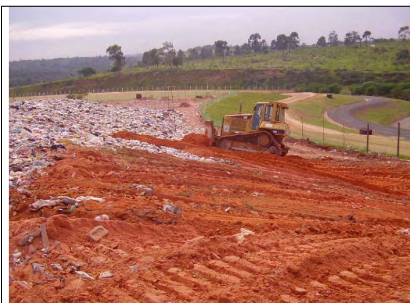
Foto III.3.3.7-2 – Lançamento, espalhamento e compactação dos solos de cobertura das camadas de resíduos do maciço
