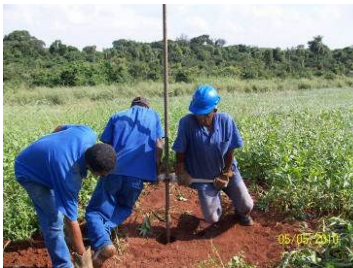
FOTO 12. Sondagem para caracterização pedológica/litológica e investigação no NA. Ao fundo se observa parte de vegetação nativa encontrada na propriedade.
