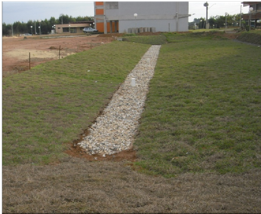
Figura 2.3.7-3 - Imagem da trincheira de infiltração.
