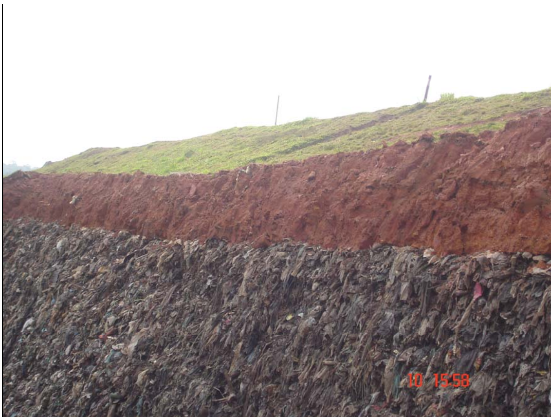
Figura 6.40 – Detalhe da camada de impermeabilização superior com argila (sem manto de PEAD)
