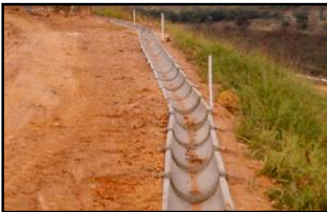
Figura 6.28 – Drenos permanentes de águas pluviais
