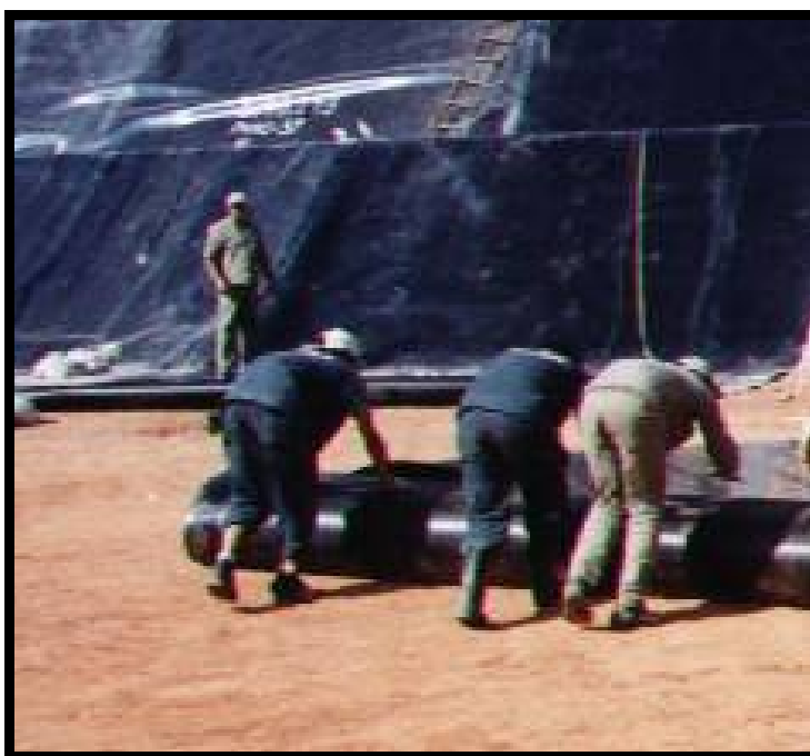
Figura 6.35 – Implantação de manta de PEAD para impermeabilização inferior.
