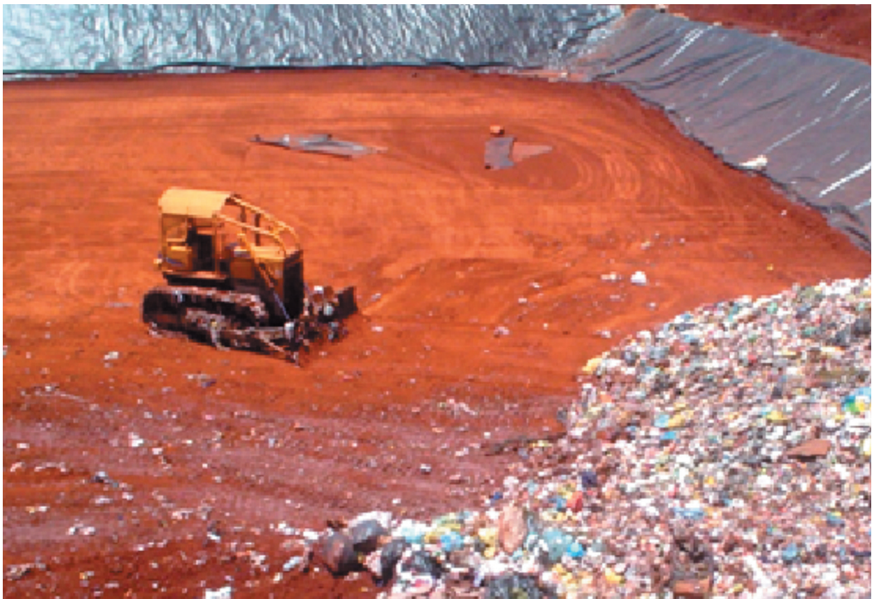
Figura 3.8. Aterro sanitário em trincheiras, evidenciando o sistema de impermeabilização de base com manta PEAD e queima de gases.
