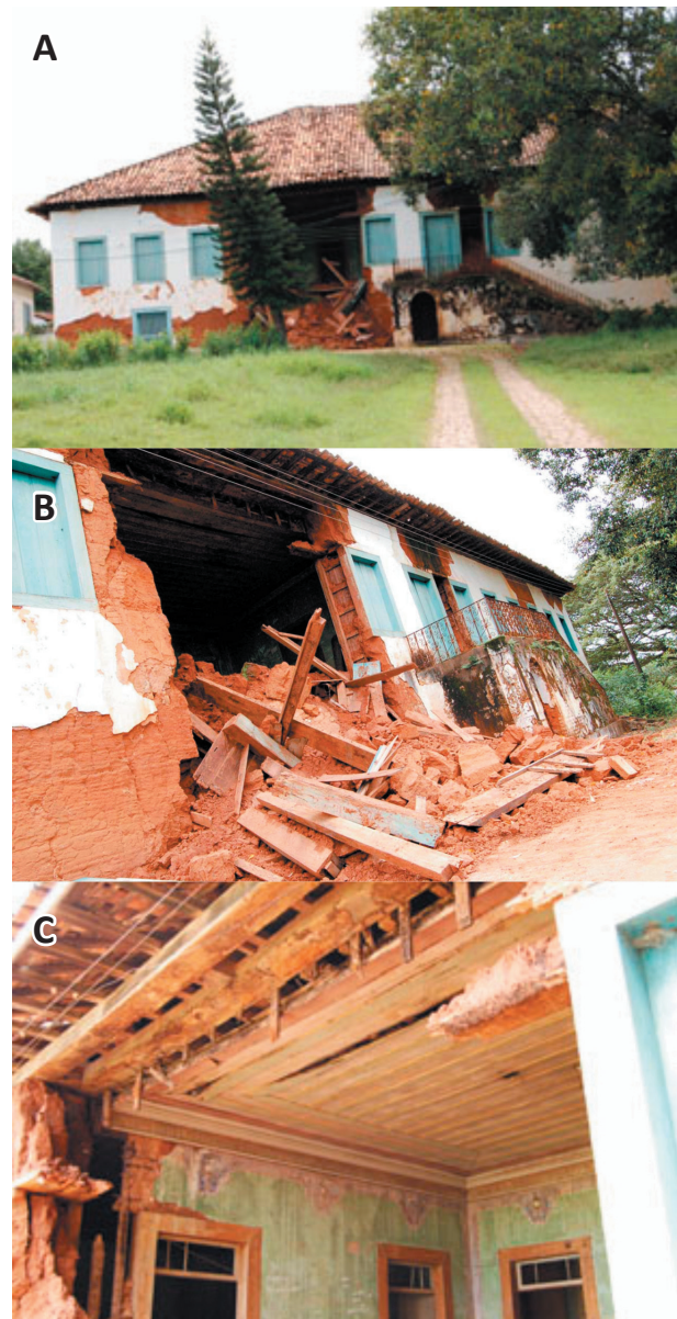
Figuras 4.107. Imagens do incidente que envolveu a queda de parte da parede do Casarão em fevereiro de 2009. (Disponível em: < http://new.gazetadelimeira.com.br/Noticia.asp?ID=17724 >). A) Vista da fachada com parte da parede ruída devido às chuvas; B) Detalhe da parede caída do Casarão; C) Detalhe do estado conservativo do telhado e forro do Casarão. Após o desmoronamento da parede.
