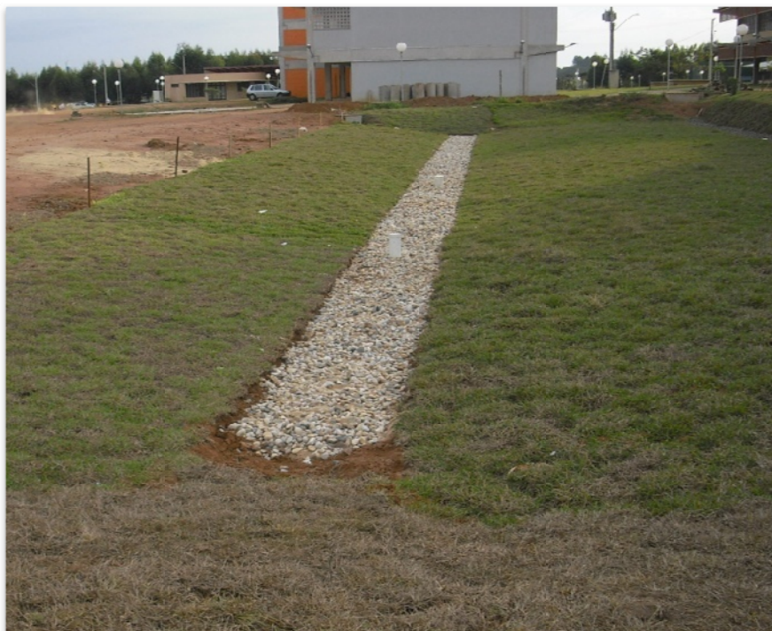
Figura 2.3.7-3 - Imagem da trincheira de infiltração.
