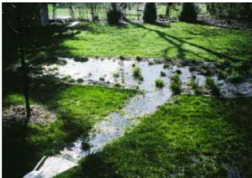
Figura 2.3.7-2 Modelo de praça filtrante, após a chuva.
