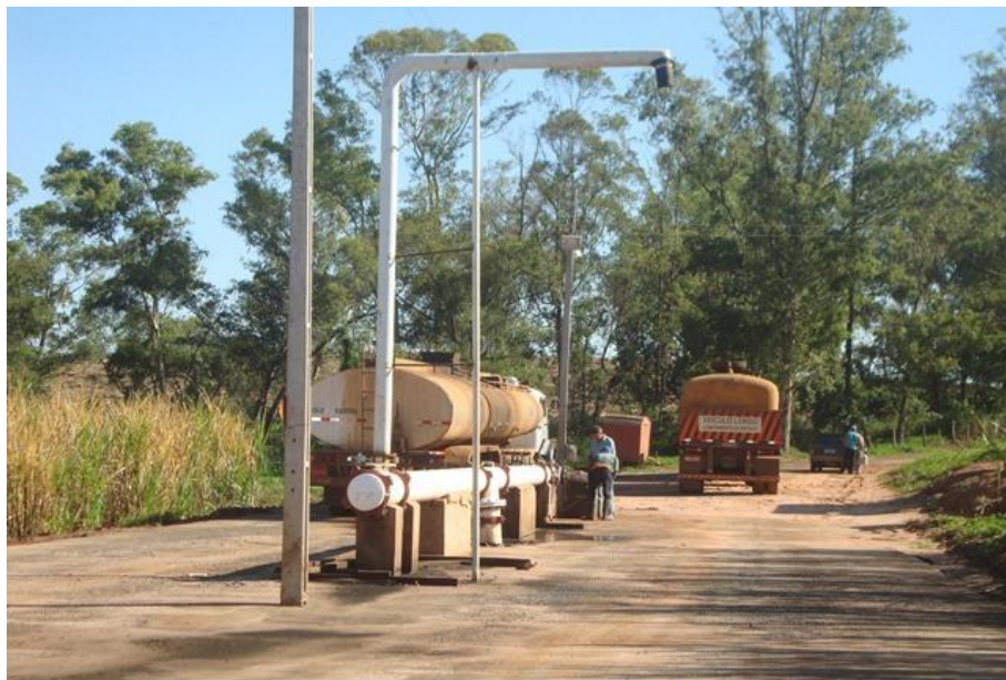
Foto 8 - Área de carregamento de vinhaça com solo impermeabilizado.
