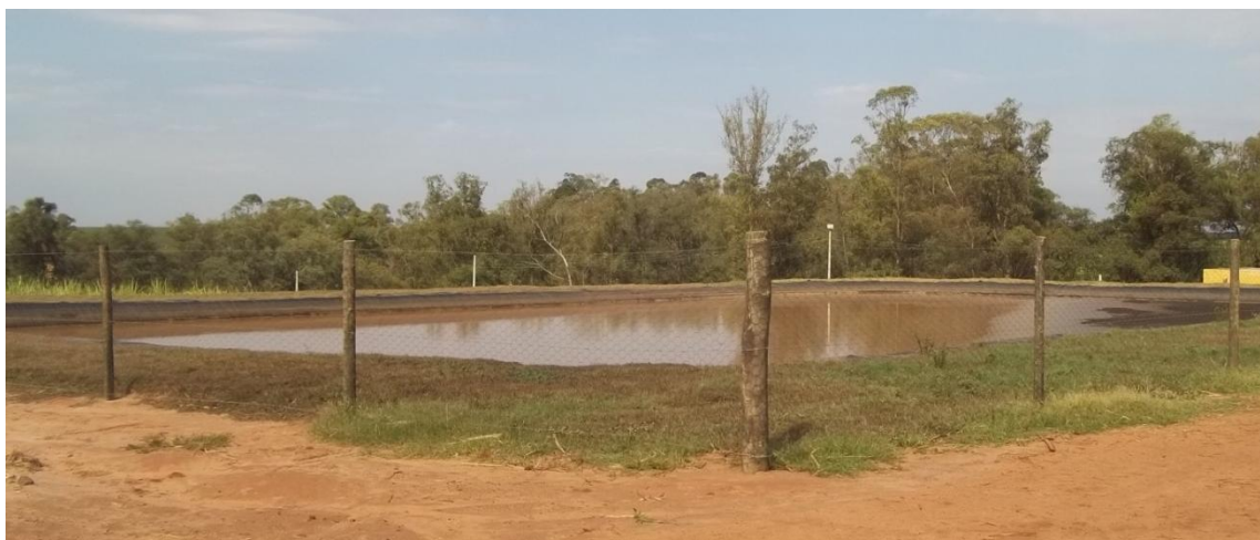
Foto 5 - Tanque de vinhaça impermeabilizado e com restrição de acesso por alambrado.
