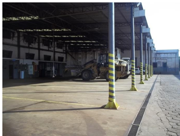
Foto 43 – Detalhe da área de manutenção de máquinas coberta e com canaleta para coleta de efluentes e águas pluviais
