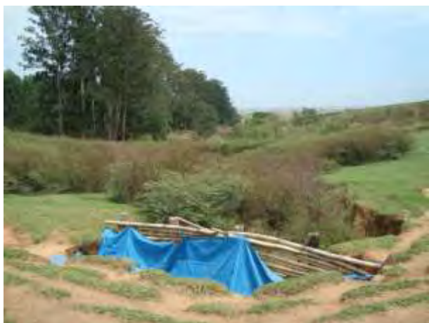
Foto 7.1.2.10-2: Km 12+950, Pista Sul, Ponto 2 – Erosão em sulco e solapamento das margens da nascente.
