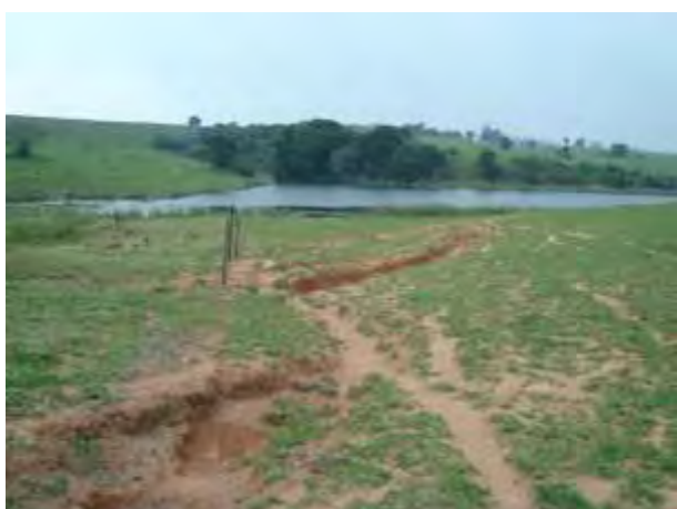
Foto 7.1.2.10-6: Km 20+400, Pista Sul, Ponto 6 – Ravina e Erosão em Sulco.
