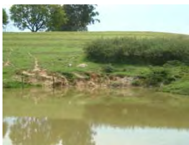
Foto 7.1.2.10-3: Km 12+950, Pista Sul, Ponto 3 - Erosão em sulco e solapamento das margens da represa.
