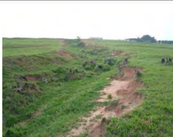
Foto 7.1.2.10-9: Km 21+250, Pista Sul, Ponto 9 – Ravina e Erosão em Sulco.
