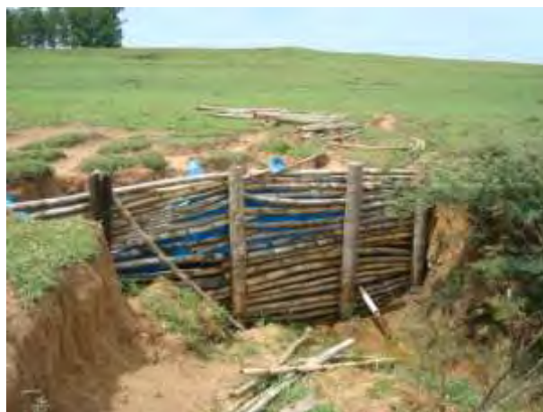
Foto 7.1.2.10-2: Km 12+950, Pista Sul, Ponto 2 – Erosão em sulco e solapamento das margens da nascente.
