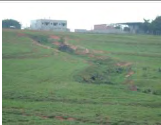
Foto 7.1.2.10-9: Km 21+250, Pista Sul, Ponto 9 – Ravina e Erosão em Sulco.
