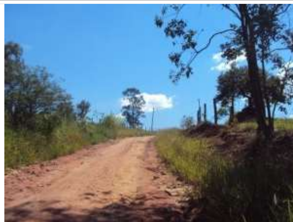
Foto 7.1.3.1-12: Estaca 1470, km 21+500 – Estrada com diversos processos erosivos superficiais.
