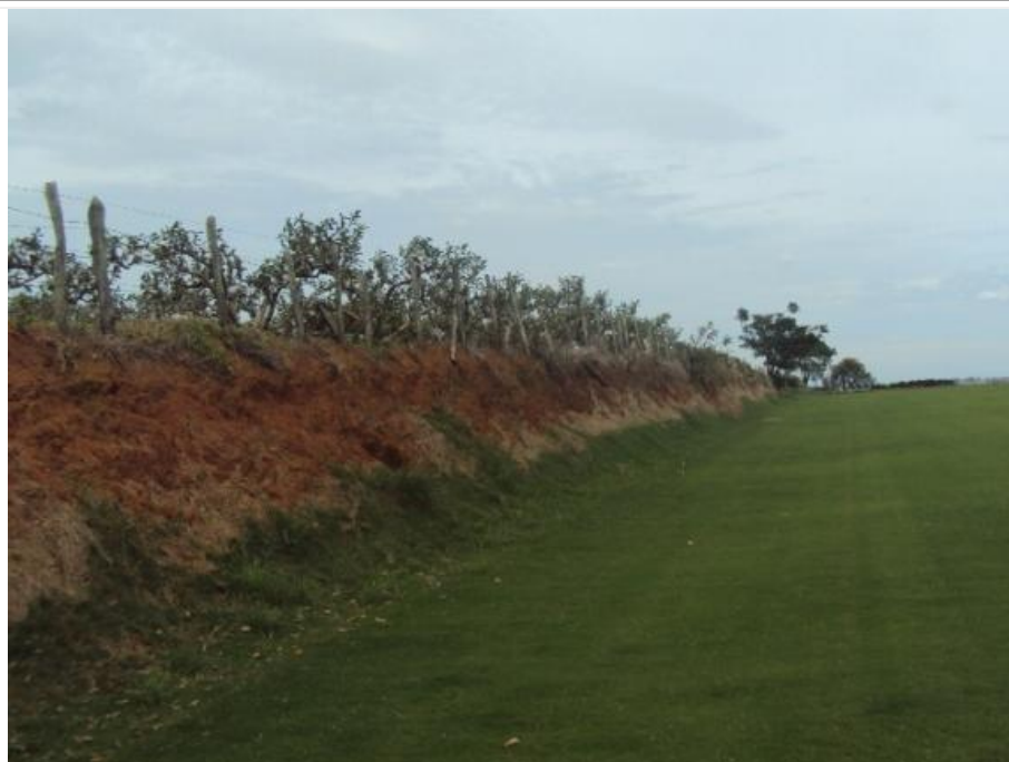
Foto 8-8: Estaca 1044, km 13+000 – sentido Indaiatuba, talude de corte com presença de argissolo vermelho-amarelo, que deverá sofrer intervenção para realização das obras.
