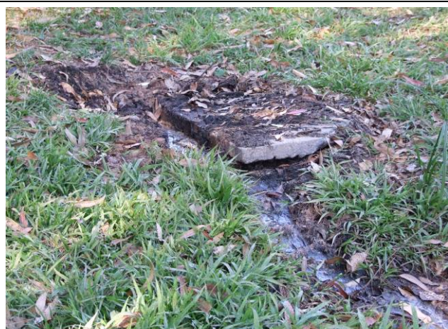
Foto 17: Detalhe do lançamento de esgoto na APP do Córrego Candelária.
