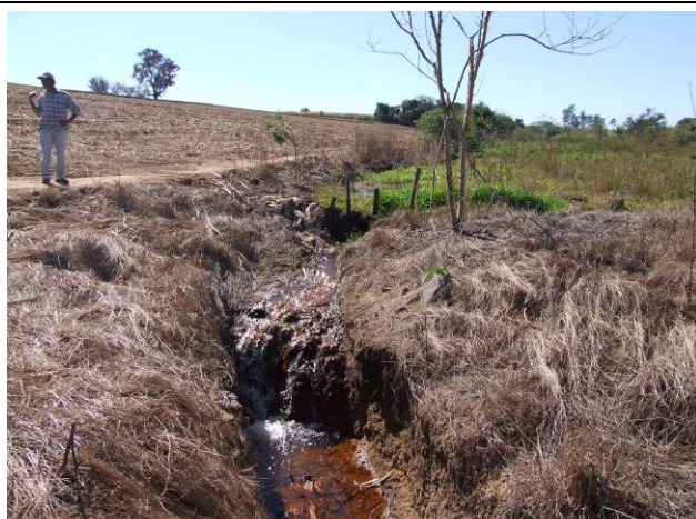
Foto 12: Barragem entulhada e rompida no Córrego da Candelária a montante da Gleba B. Notar que o plantio de cana se estende até a beira da planície fluvial que não apresenta mata ciliar na APP.
