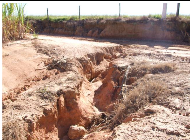
Foto 24: Erosão em sulco e erosão laminar em trecho de solo exposto, nos cortes e ao longo das estradas.
