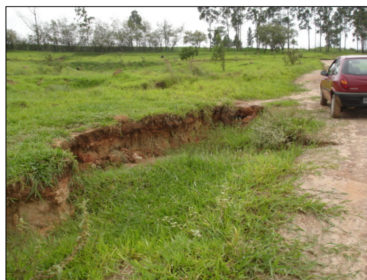
Foco erosivo, originado da concentração do fluxo da água na lateral da estrada, que não possuía nenhum mecanismo de dissipação de energia.
