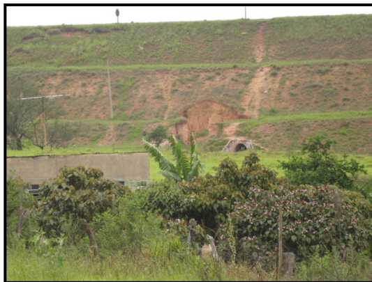
Movimento de massa, em aterro da rodovia Santos Dumont, ocorrido possivelmente por conta de mau dimensionamento do sistema de drenagem, associado a um processo erosivo.
