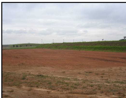
Processo erosivo laminar dentro do sítio aeroportuário, originário das obras de terraplenagem para ampliação da pista e/ou pela área ter sido destinada como área de empréstimo das obras recentes de ampliação do aeroporto.
