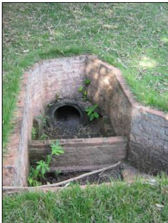
Foto 5.2.5.1-5: Vista do sistema de caixa filtro implantada na saída da lagoa de decantação de sedimentos.
