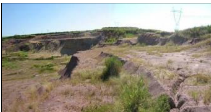
Foto 5.2.2.3- 1: Aspectos das áreas escavadas para a retirada da argila. Os taludes se mostram relativamente íngremes e deverão ser readequados para evitar desequilíbrios.
