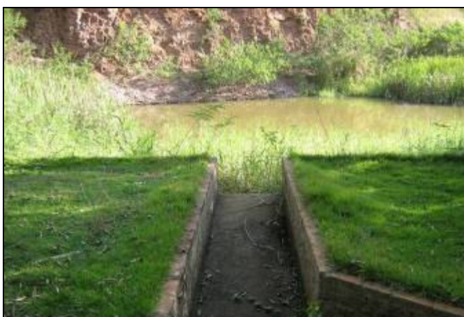
Foto 5.2.5.1-4: Na saída da lagoa de decantação dos sedimentos foi implantado sistema de canaletas de controle do escoamento e filtros.
