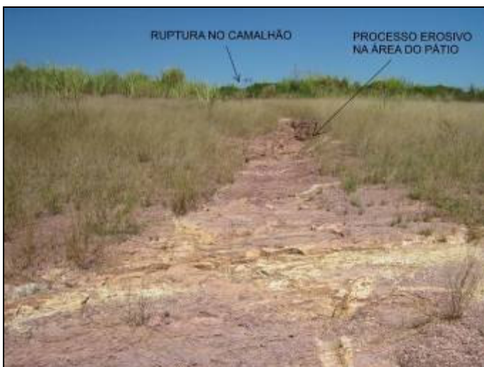
Foto 5.2.2.2-8: Aspecto de uma das rupturas do camalhão e do processo erosivo na área do pátio de secagem do minério.
