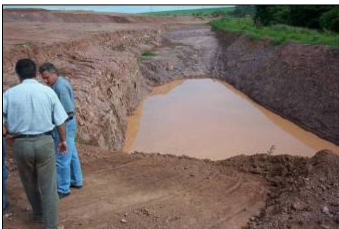
Foto 5.2.2.2-7: Aspectos da implantação da caixa de retenção de águas pluviais e de sedimentos.
