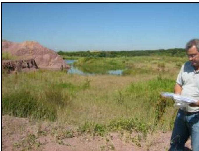
Foto 5.2.2.3-3: Vista da caixa de decantação de sedimentos (em primeiro plano). Esta caixa se mostra com vegetação de gramínea que se desenvolveu em decorrência da suspensão das atividades de mineração. Ao fundo aparece o alagamento, também formado pela paralisação das atividades.
