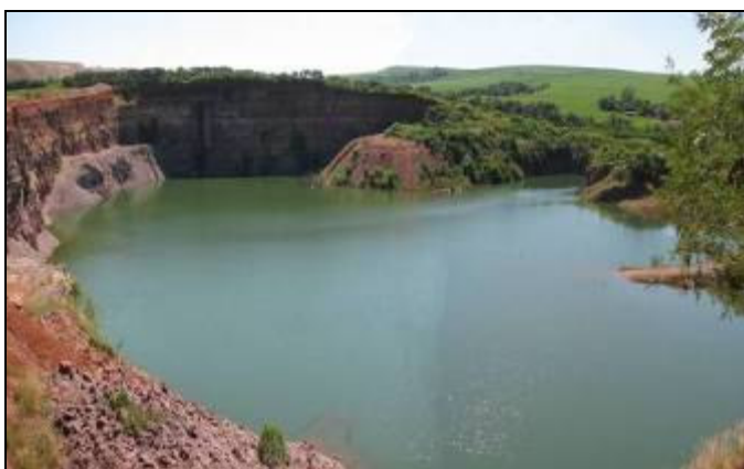
Foto 5.2.5.1-1: Vista geral da cava formada pela retirada do minério. Esta cava se encontra inundada. Os taludes se mostram relativamente íngremes.
