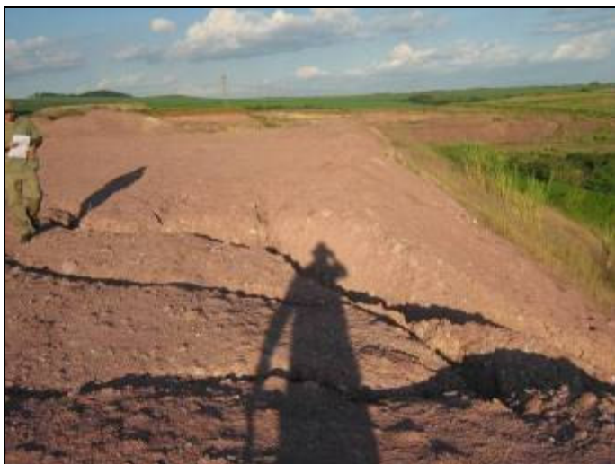
Foto 5.2.1.1-2: Sulcos de erosão no talude do depósito de argila. Neste trecho a crista do talude se encontra sem o cordão que controla o escoamento das águas pluviais.
