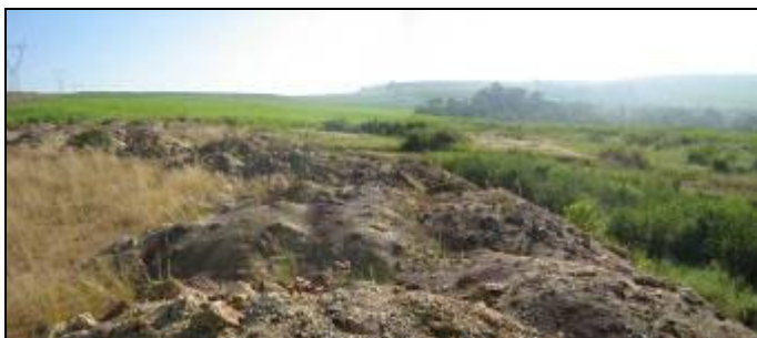
Foto 5.2.1.2- 8: Neste depósito de argila, foram estabelecidas leiras (com o próprio minério) nas cristas dos taludes para evitar o escoamento das águas pluviais.
