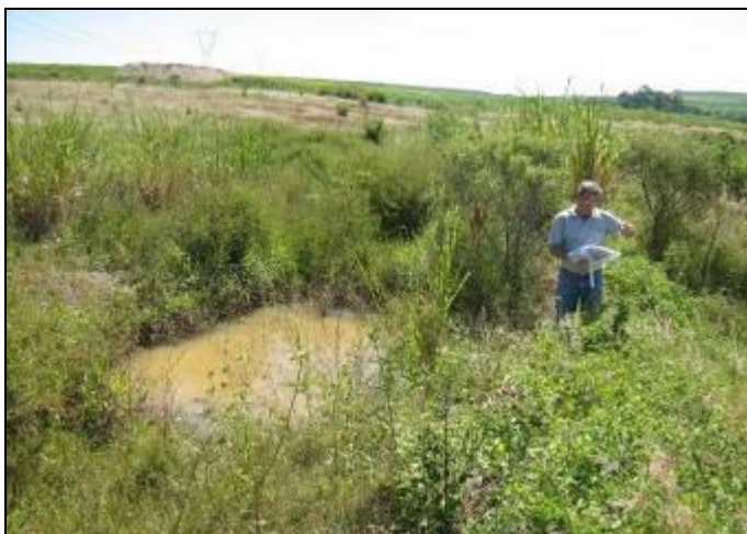
Foto 5.2.2.3-7: Aspecto da caixa de retenção e decantação de águas pluviais e de argila.
