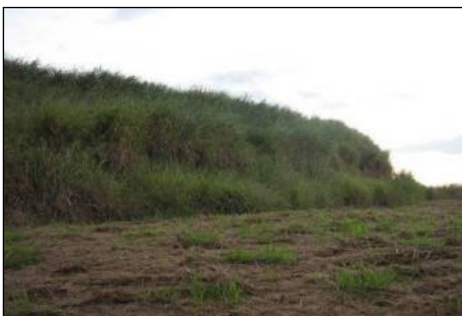
Foto 5.2.3.3-4: O depósito de solos se mostra com densa cobertura de vegetação de gramíneas. Não foram encontrados sinais de processos erosivos. As alterações nas paisagens, na topografia, drenagem natural dos terrenos configuram passivos.
