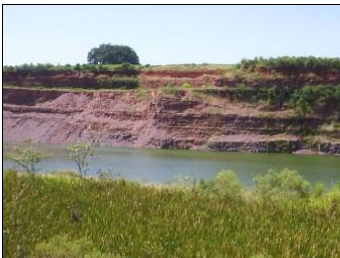
Foto 5.1.9-1: Taludes e bermas da área lavrada – porção nordeste - situada dentro dos limites da poligonal do processo DNPM 820.415/99.
