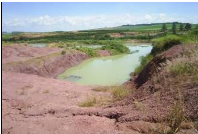
Foto 5.2.4-2: Aspectos da cava formada pela mineração. A cava se encontra inundada e os taludes se mostram relativamente verticalizados.
