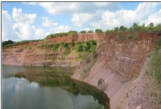
Foto 5.2.9.1-1: A cava se encontra totalmente alagada em decorrência da paralisação das atividades. Os taludes estabelecidos pelas escavações se mostram relativamente acentuados.
