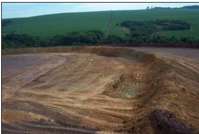
Foto 5.2.2.2-6: Os terraços apresentam dimensões relativamente grandes, no entanto em alguns pontos houveram rupturas devido a processos erosivos.
