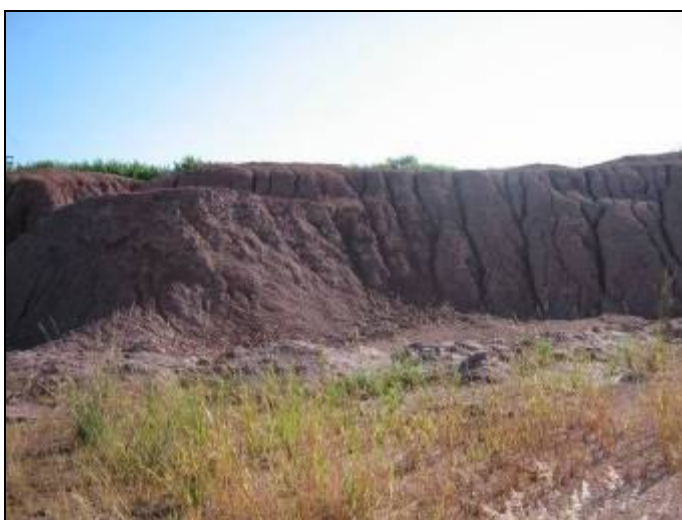
Foto 5.2.1.2-2: Parte dos taludes de cortes da cava se mostra com processos erosivos. As águas pluviais que provocam esta erosão se dirigem para os sistemas de decantação já estabelecidos para esta mineração.
