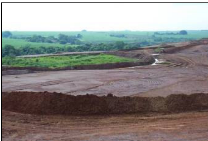
Foto 5.2.2.2-5: Aspecto da implantação dos camalhões (terraços) do pátio de secagem da argila.
