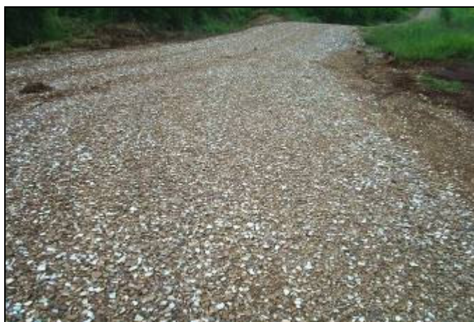
Foto 5.4.5.4-1: Detalhe de acesso não pavimentado ao Complexo Argileiro, recoberto com material cerâmico em pequenos pedaços e com acentuada redução de poeiras geradas pelo tráfego de veículos, notadamente caminhões.
