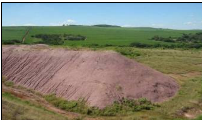
Foto 5.2.2.2-3: O depósito de argila (DNPM 820.525/99) apresenta inúmeros sulcos de erosão no seu talude. O material carreado era detido nas caixas de decantação do pátio de secagem de argila situado à jusante (lado direito da foto).
