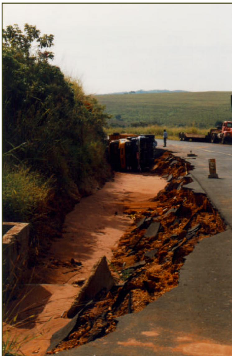
DS. 13 - Rodovia de ligação Anhembi/Piracicaba, porção sul da AII. Observa-se erosão da estrada gerada pelo escoamento concentrado das águas pluviais, devido ao sistema de drenagem inadequado.
