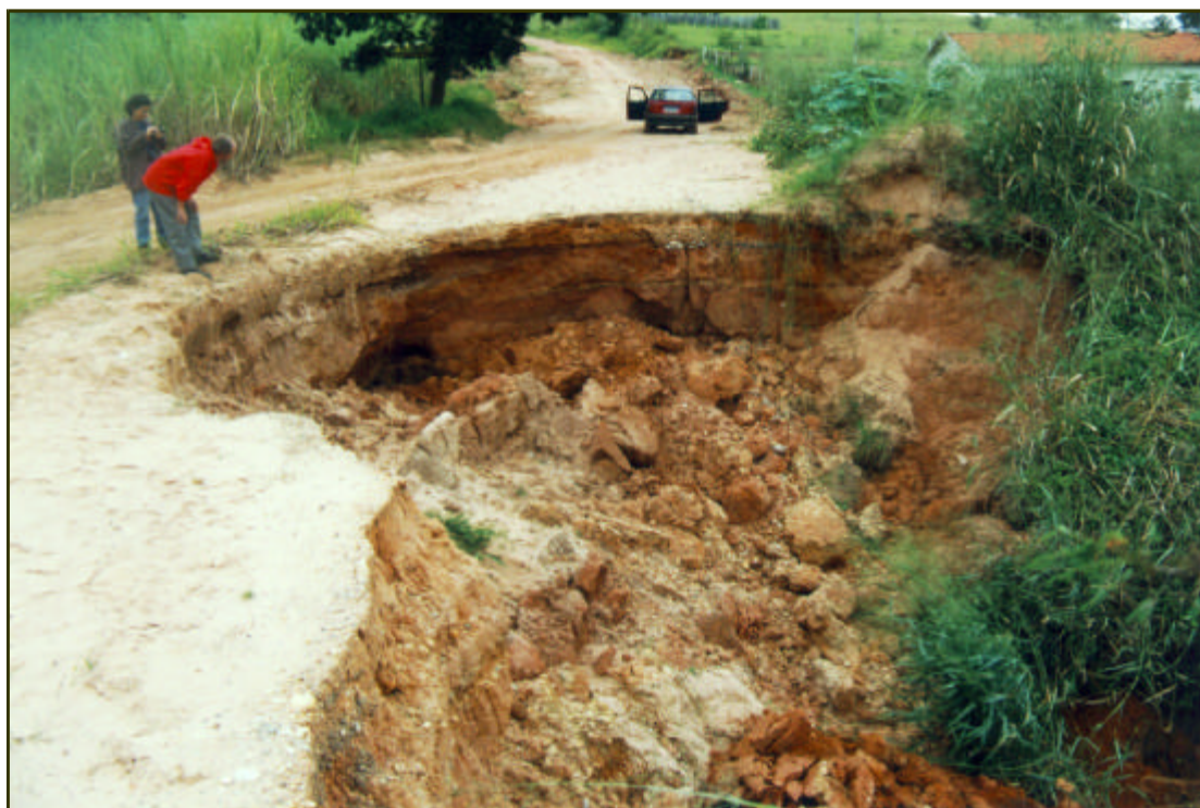
DS.17 - Boçoroca do Ribeirão Paredão Vermelho, afluente da margem esquerda do Rio Piracicaba. Observa-se o processo erosivo em contrapartida à degradação da estrada.
