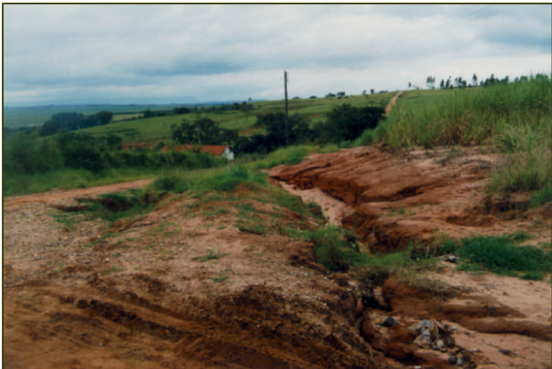
DS.19 - Erosão no leito da estrada que corta o Ribeirão Paredão Vermelho. Nota-se a movimentação de terra para contenção da erosão, no entanto acentuando o carreamento de sedimentos para o referido curso.
