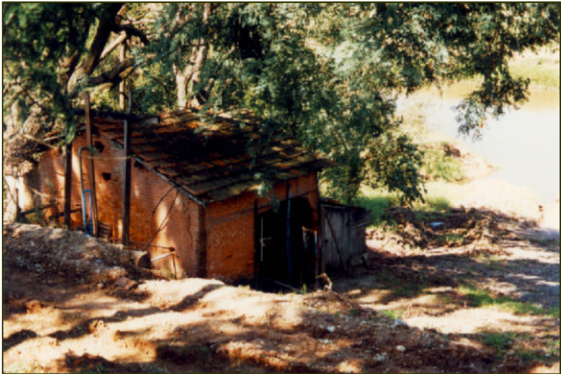
RHS. 5 - Nauti Clube Bela Vista. Nota-se as condições precárias de proteção do poço de abastecimento de água, situado na margem do Rio Piracicaba. À direita, o rio.
