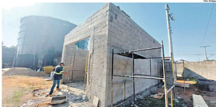
O Departamento de Água e Esgoto tem a previsão de inaugurar dois novos reservatórios de água em 2025, nos bairros Parque Gramado e São Vito, beneficiando cerca de 50 mil moradores, praticamente um quarto do total da cidade, em busca de garantir o abastecimento por meio dos mananciais já existentes
