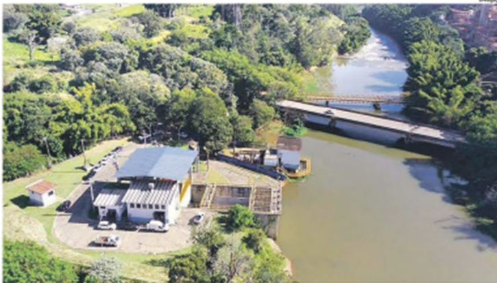
Estação de captação de água do Rio Piracicaba, em Americana, o município, junto com Nova Odessa, apresenta situação preocupante em relação à segurança hídrica, segundo a Agência das Bacias PCJ
